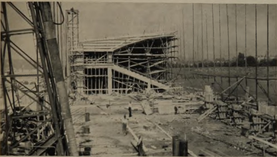
7 Tribünenbau in der Ausführung Eisenbetonbau mit frei ohne Stützen 14 m weit vorgekragtem Dach. Einzelfundamente z. T. Pfahlgründung
