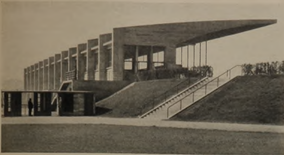
6 Tribünenbau Mit Absperriegitter und Aufgängen zur Tribüne, sowie zu den ungedeckten Sitzen
