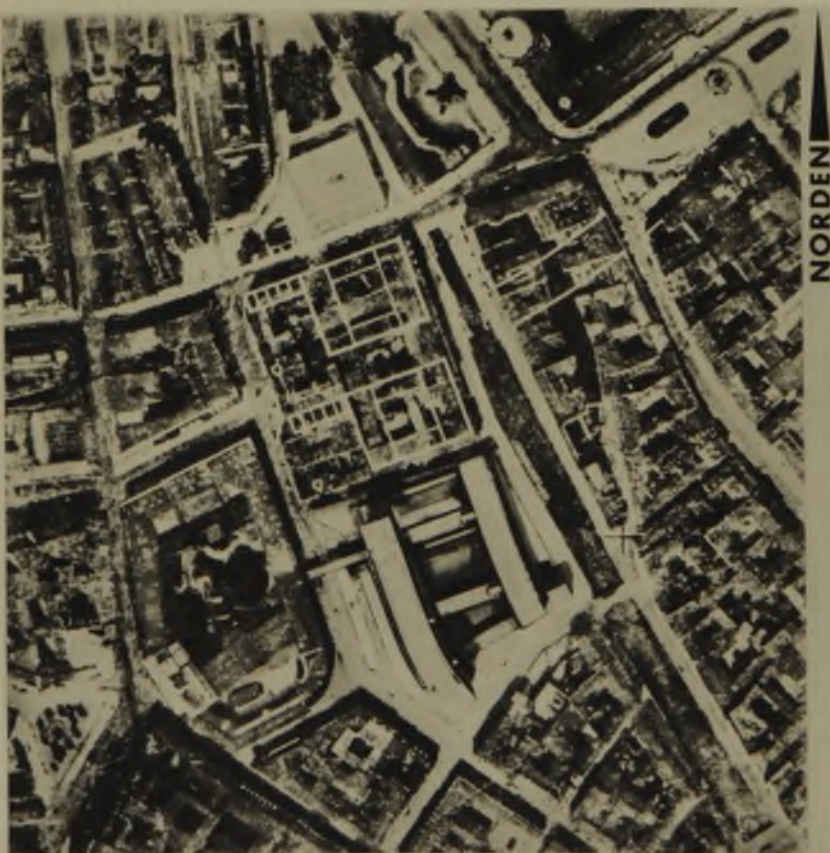
Der Werdersche Markt ist zu einer Platzfolge umgestaltet. Zusammen mit dem Gendarmenmarkt, dem Schloßplatz, dem Friedrichsforum und dem Lustgarten entsteht auf diese Weise ein Kranz wirkungsvoller Plätze
