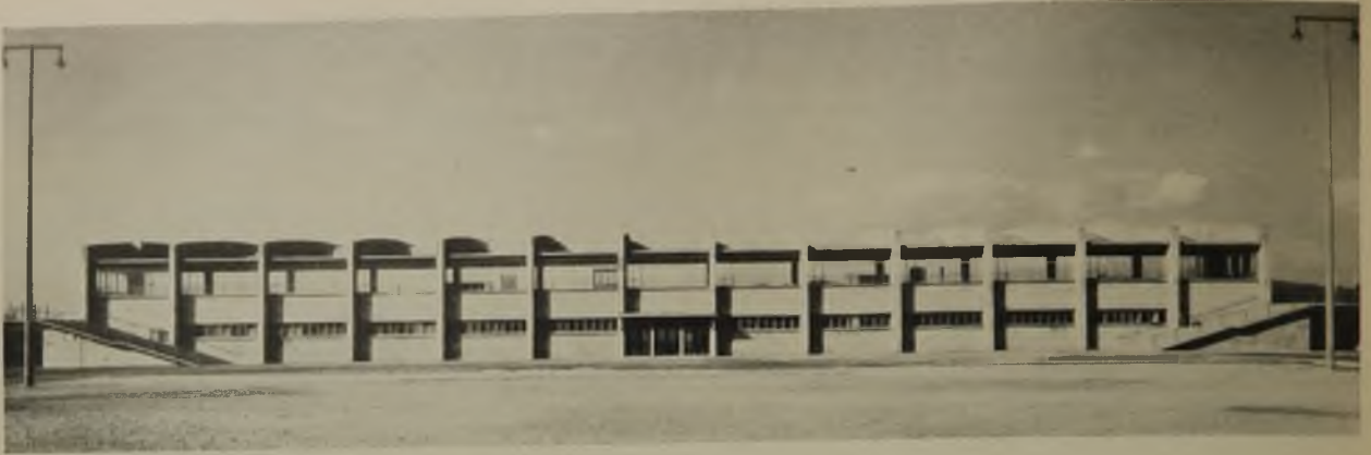
4 (oben) Gesamtansicht des Tribünenbaues nach der Wernerstraße (Ausführung in Eisenbeton)
