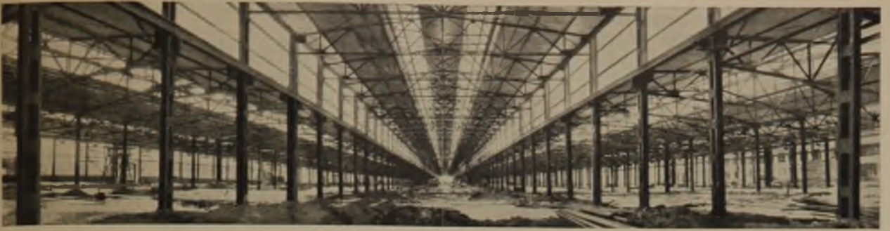
1 Blick in die Montagehalle der Automobilfabrik Nischnij Nowgorod. Größte Montagehalle Europas. 6 Schiffe von je 18 m Spannweite. Lieferung der Konstruktion: Gollnow & Sohn, Stettin. 4400 t Stahl
