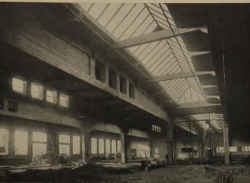
5 Scheiben-Wandträger von großer Spannweite
