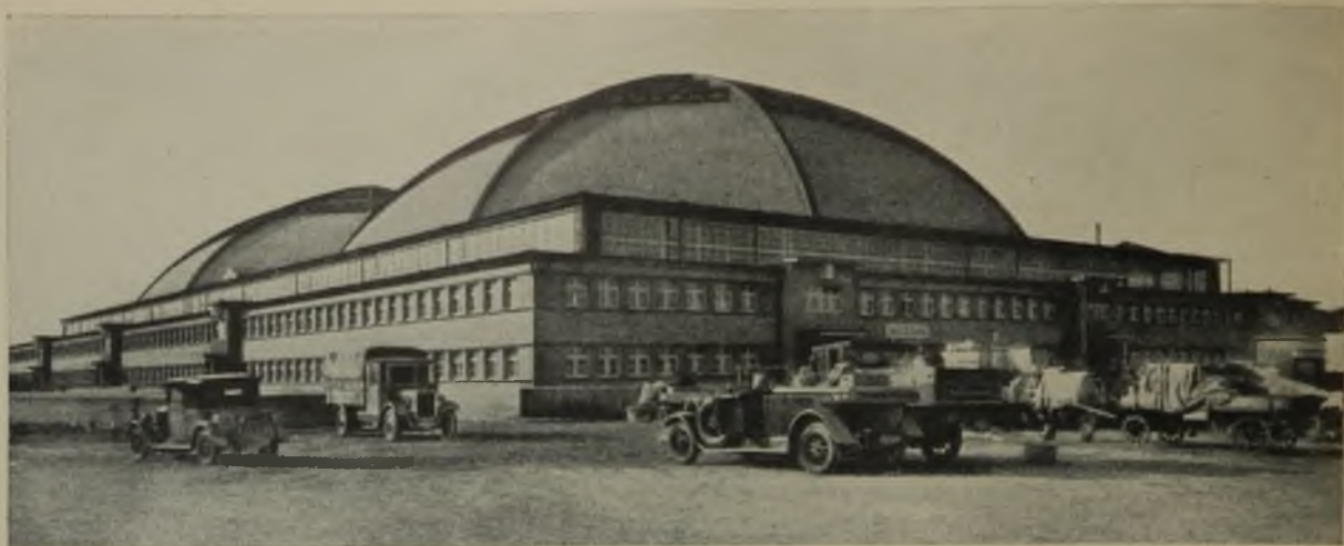
7 u. 8 Markthalle in Leipzig. Außen und innen. Kuppelschalen System Zeiß Dywidag
