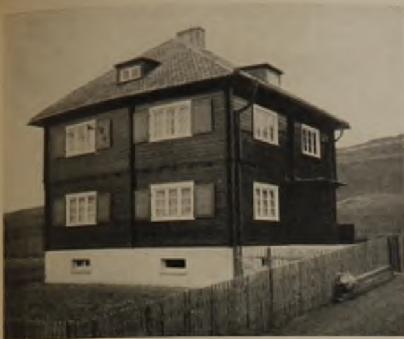
4 Staatl. Forsthaus Niederaula b. Kassel Holzfachwerkbau mit Holzverschalung. Aufnahme Kleiber
