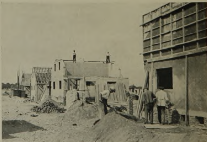
9 Leichtbeton in der Stadtrandsiedlung
