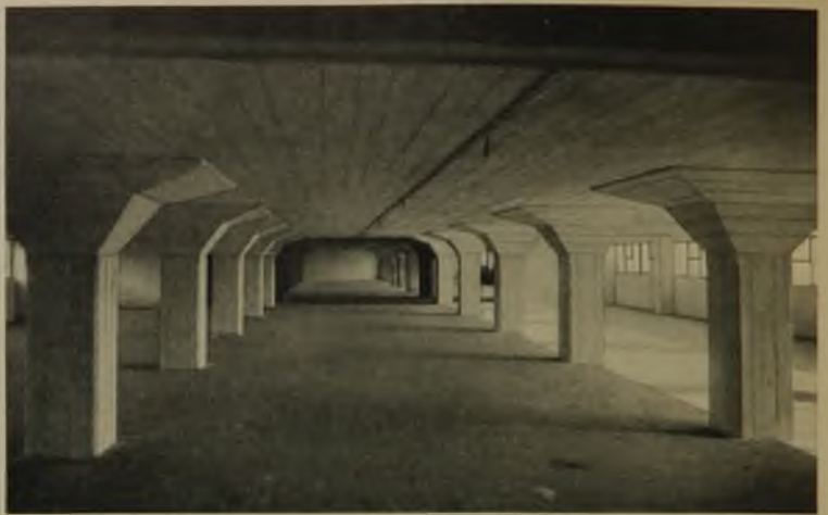
2 Eisenbetondecken ohne Unterzüge (Pilzdecke) für schwere Lasten
