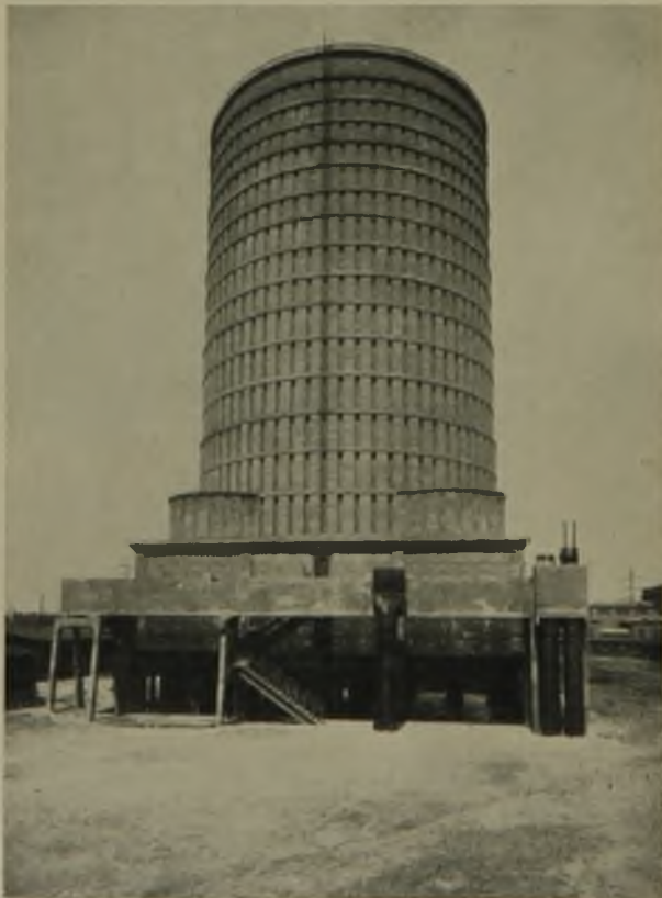
3 Hohlzylinder von großem Durchmesser als Kühlturm
