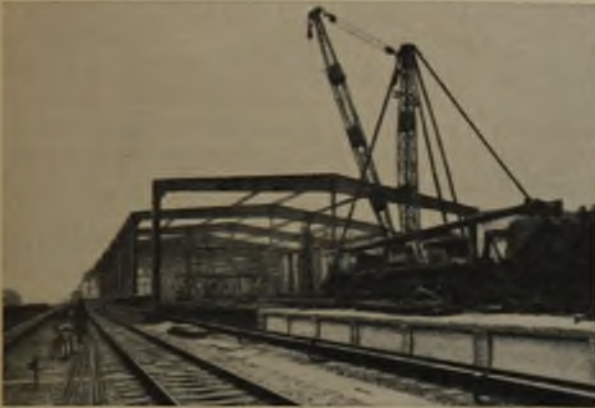
2 u. 3 Umsteigebahnhof Schöneberg der Wannsee- und Ringbahn in Berlin. Geschweißter Rahmen von 18,5 m Spannweite. (Vgl. auch DBZ 1933, Nr. 25)
