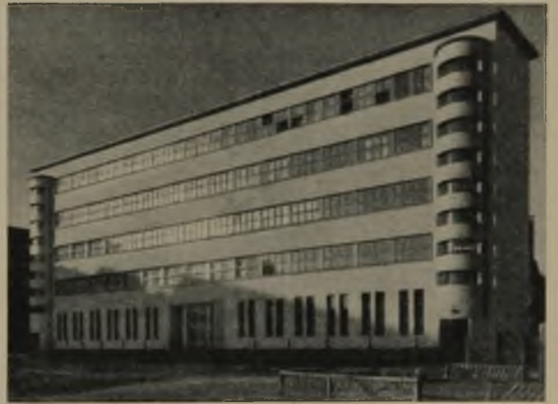
4 u. 5 Postneubau Berlin-Wilmersdorf am Hochmeisterplatz. 5-geschossiger Stahlskelett-Hochbau, mit weit gespannten Decken mit ebener Untersicht. (Näheres „Stahlbau“ 1933, Heft 9)
