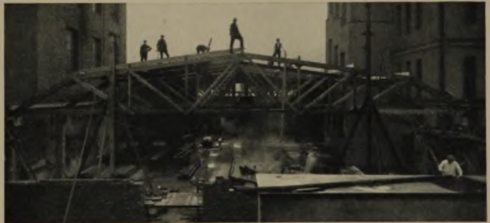
2 Dachstuhl der Tuchfabrik Wolf in Kirchberg (25 m freie Spannweite. Berechnung und Ausführung Dipl.-Ing. Erich Seidel, Leipzig)
