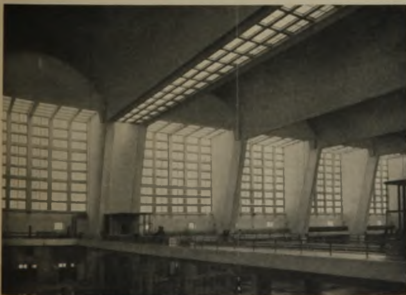
6 Tonnenschalen in der Großmarkthalle Frankfurt-M. System Dywidag
