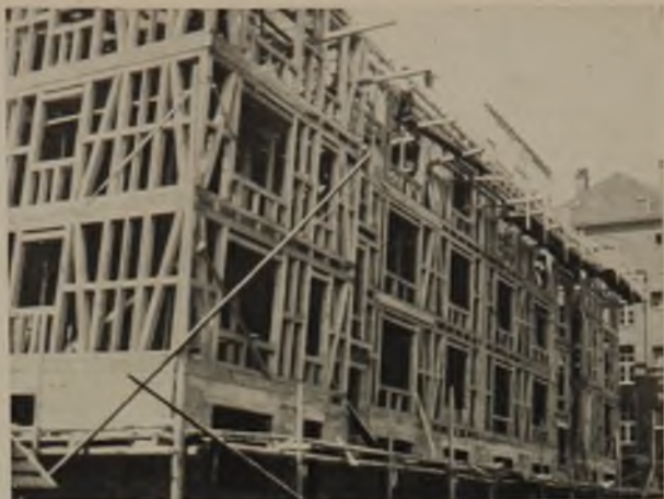
5 Holzskelett für 9-Wohnunghaus in Cannstatt Ausführung 1933
