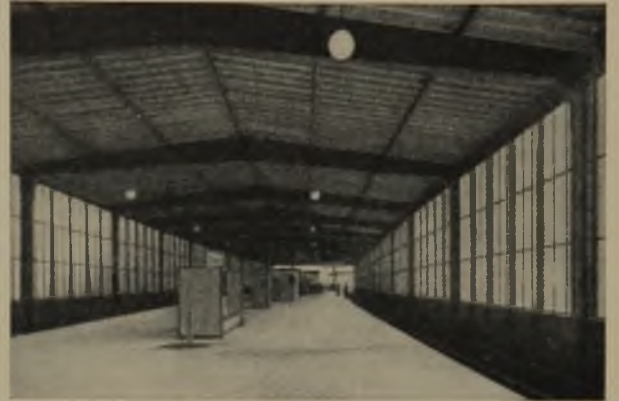
2 u. 3 Umsteigebahnhof Schöneberg der Wannsee- und Ringbahn in Berlin. Geschweißter Rahmen von 18,5 m Spannweite. (Vgl. auch DBZ 1933, Nr. 25)
