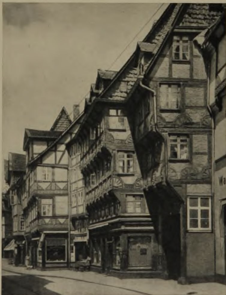
Zu erhaltende alte Häuser, aber Räumung der Hinterhöfe von aller späteren Bebauung
