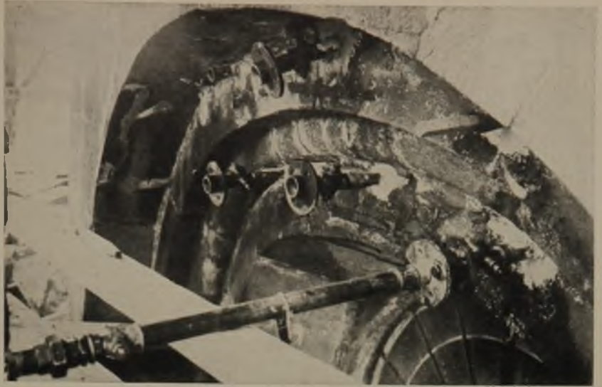
5 u. 6 Einpreßstutzen zur Mörtleinpressung am Speyerer Dom. Arbeiten an einer Wand und einem Fensterbogen
