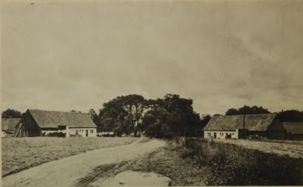
Der Beschauer ist sich im ersten Augenblick nicht darüber im klaren, ob es eine alte oder eine neue Siedlung ist, so selbstverständlich ist sie an einer alten Linden-gruppe an einer Wegkreuzung angelegt. (Rentengutsiedlung Kapkeim, Ostpreußen)
