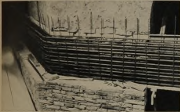
17 Eisengeflecht eines Eisenbetonankers
