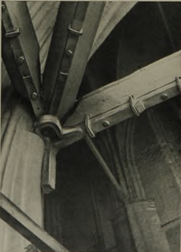
13 (oben) Inneres der St.-Katharinen-Kirche in Hamburg mit alten Holzankern vor der Wiederherstellung
