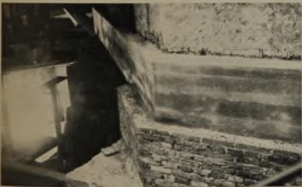
18 Fertiger Eisenbetonanker für den Westturm des Doms zu Speyer
