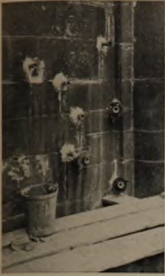
5 u. 6 Einpreßstutzen zur Mörtleinpressung am Speyerer Dom. Arbeiten an einer Wand und einem Fensterbogen
