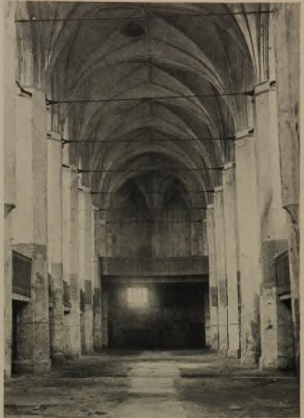
10 Hochschiff St.-Johannis-Kirche, Stettin, mit Eisenankern statt der alten Holzanker
