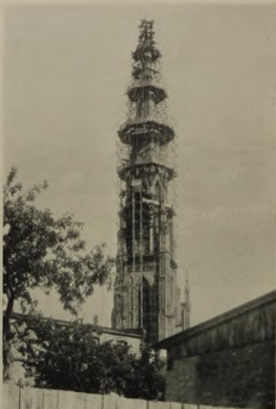
1 Einrüstung des Turmes d. St. Marien-Kirche i. Königsberg Nm. Torkret-Stahlrohrgerüst
