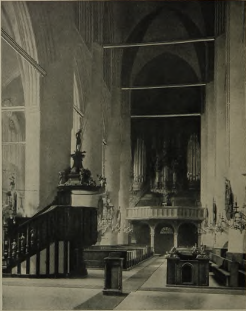
13 (oben) Inneres der St.-Katharinen-Kirche in Hamburg mit alten Holzankern vor der Wiederherstellung
