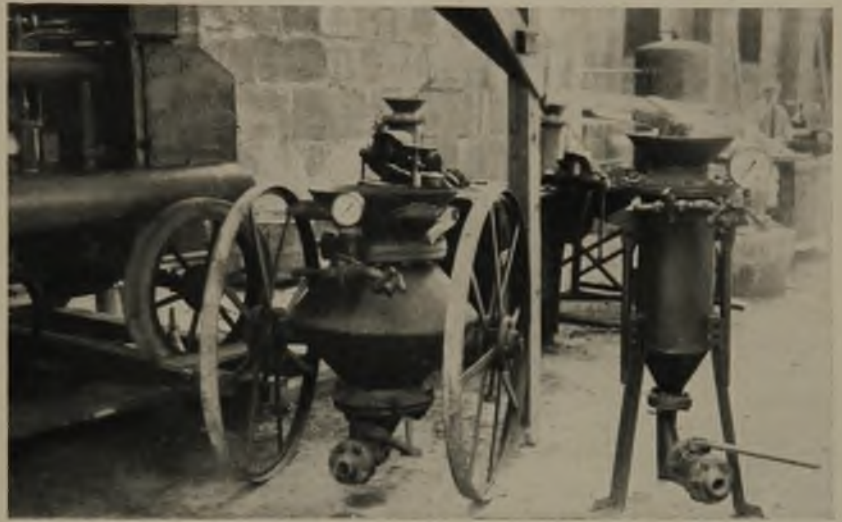
5 u. 6 Einpreßstutzen zur Mörtleinpressung am Speyerer Dom. Arbeiten an einer Wand und einem Fensterbogen
