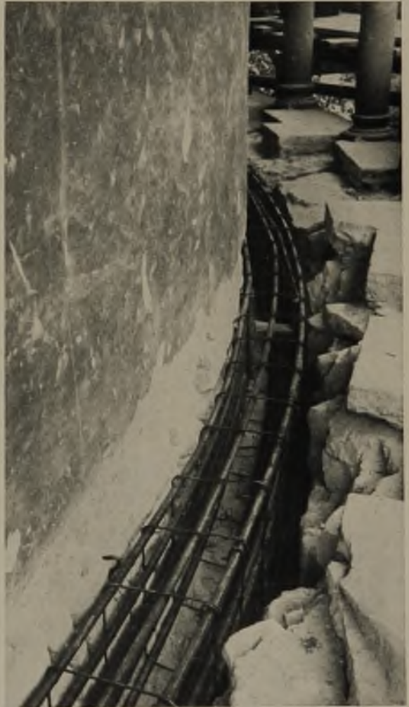
19 Eiseneinlagen des Eisenbetonankers für den Chor des Doms zu Speyer
