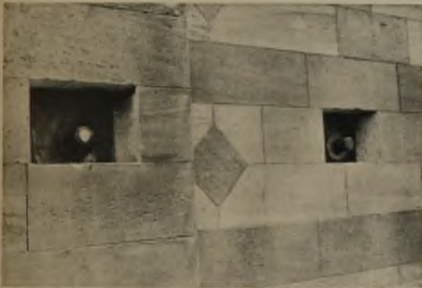
11 Ankerenden, die durch Werksteinverblendung verdeckt werden
