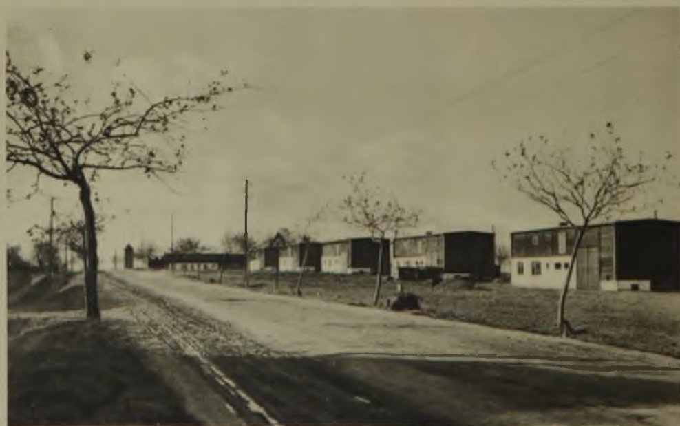
Überall in Deutschland gibt es Ansätze zu einer kernigen starken Baugestaltung (Landarbeiterstellen der Rentengutsiedlung Mittelhagen)
