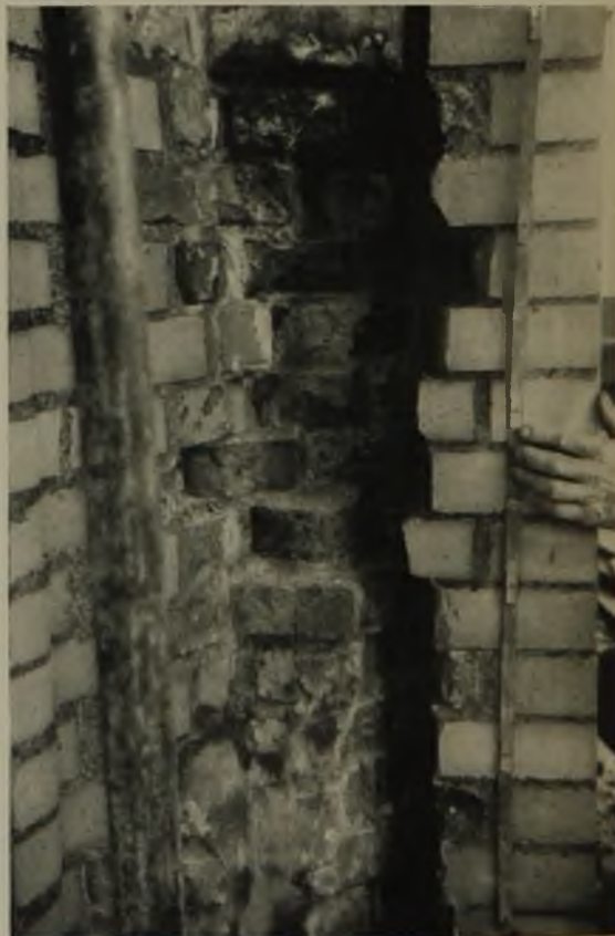
Zustand nach Beseitigung des verwitterten Materials
