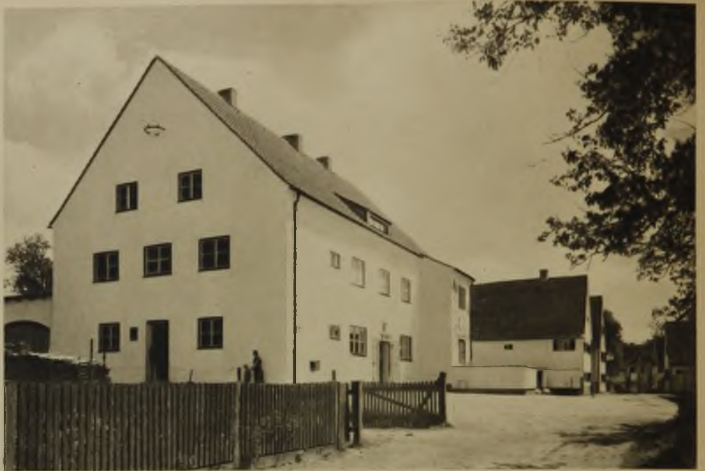
Marktflecken in Mittelschwaben. Einfache Bauernhäuser mit Giebeldach typisch. Das Haus steht an einer engen Dorfstraße. Es mußte gegen die Häuserflucht etwas zurückgerückt werden, um für Postkraftwagen einen kleinen Anfahrtsplatz zu gewinnen. Um wieder den Anschluß an die Häuserfront der Straße zu gewinnen, wurde der Erkervorbau vorgezogen
