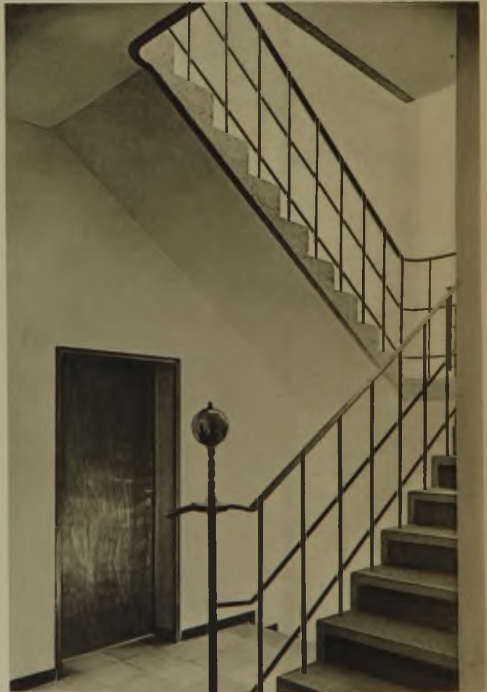
Treppe Eisenbeton; Untersicht geputzt, sonst gestackt (Betonzusatz Granitkleingeschläge). Geländer Schmiedeeisen, schwarzgrau gestrichen, mit Handleiste in Rotbronze. Tür in Bronze, Füllung Drahtspiegelglas. Putzteile weiß gekalkt
