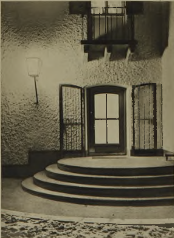
Seiteneingang. Tür aus Lärchenholz geölt, Leuchte, Gittertür und Balkongeländer Schmiedeeisen. Treppe aus Contex-Beton
