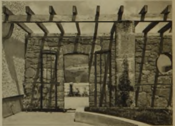
Pergola. Bruchstein aus der Umgebung von Oberstdorf. Farbe: Schwarzgrün, die Bruchflächen tiefrot, die allmählich oxydieren. Nur die Säulen an den Fugen glatt verstrichen. Die Mauern sind nicht gefugt; Mörtel nur soweit sichtbar, als er beim Vermauern der Steine vorquillt. Obere Abdeckung Stampfbeton mit Mauerwerk bündig. Holzwerk: Handbehauenes Lärchenholz
