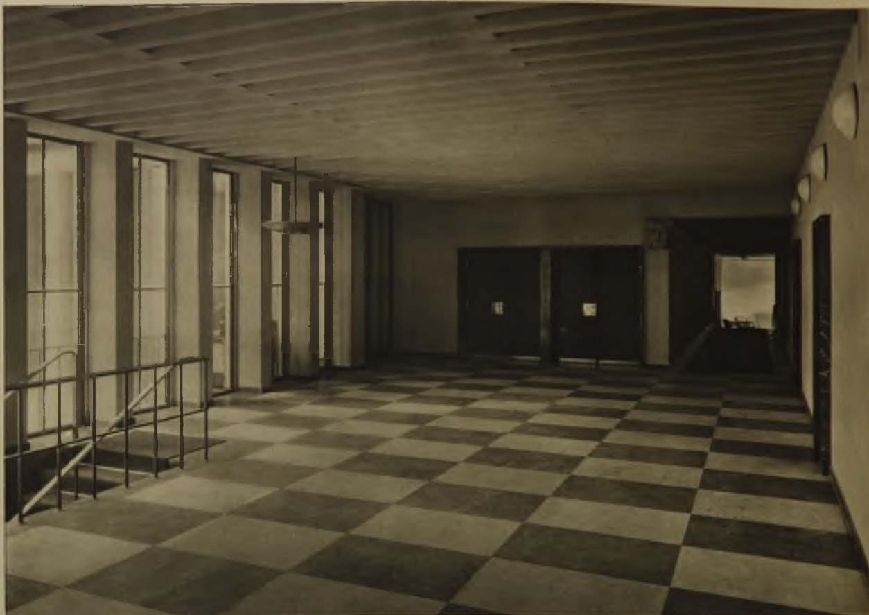
Direktionshalle im Obergeschoß. Merkurkopf von Bildhauer Willy Meller, Köln. Türen Palisander. Griffe Nirosta. Decke sichtbare Konstruktion der Betonrippendecke mit Terranovaputz wie die Wand. Treppengeländer Schmiedeeisen mit Weißmetallhandlauf. Ausmaße 12,50 mal 6,92 m
