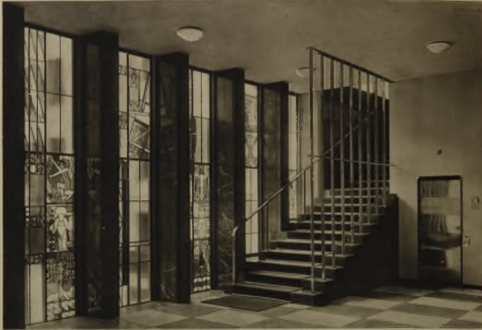
Direktionstreppe der Eingangshalle. Pfeiler dunkler Marmor. Geländer und Tür Nirosta
