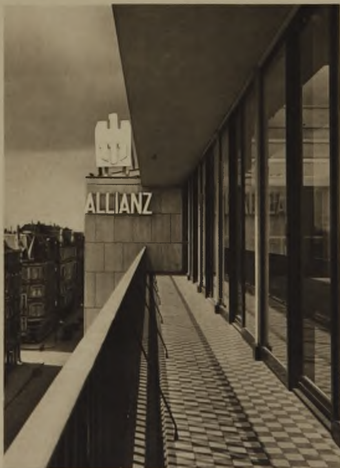
Dachgeschoßgang. Ausgekragte Betondeckenplatten in Dyckerhoff-Weiss-Zement verputzt. Fenster-Türen in horizontal verschiebbarer Holzkonstruktion. Fußboden schwarzweiße Tonplatten 10 mal 10 cm groß. Geländer rot gestrichenes Schmiedeeisen
