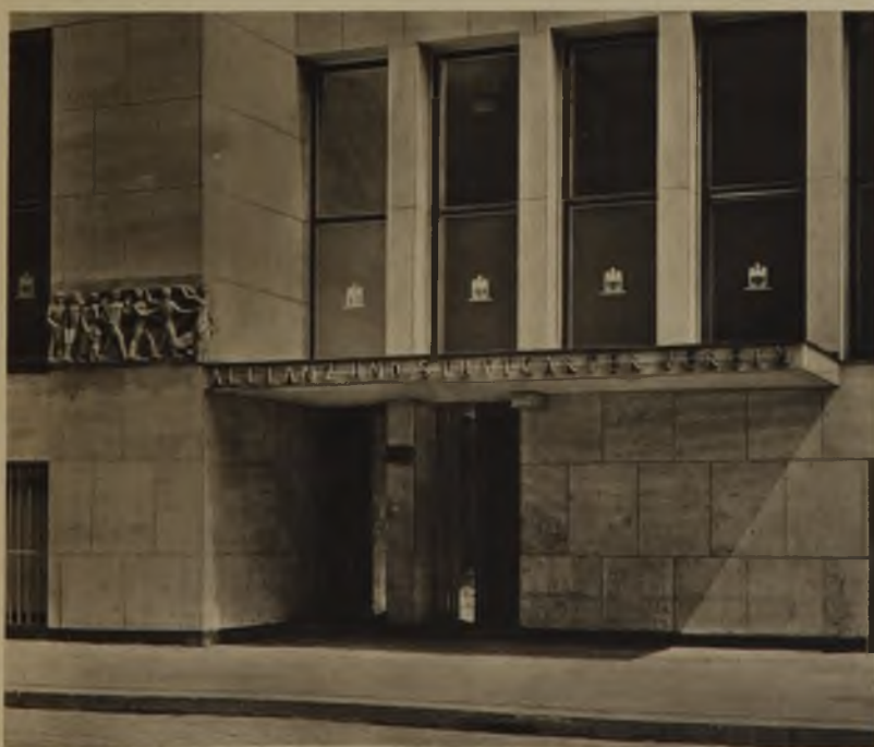
Beamteneingang. Verkleidung aus Gronsdorfer Kalkstein. Tür schwarzer Mattschleiflack mit Nirostabeschlag. Plastik Bildhauer Wilhelm Oly-Frankfurt a. M.
