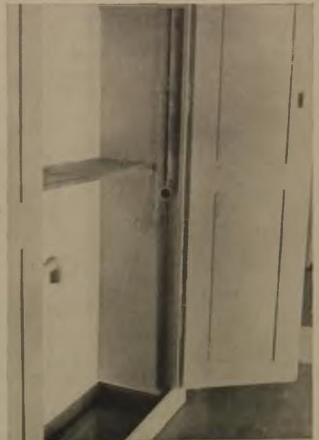
stränge zeigt Bild 4, auf dem man deutlich rechts den totgelegten, alten Ableitungsstrang wie auch die neue Leitung zum Stromautomaten und Gasherd erkennen kann. Die alte Zählernische wurde auf diese Weise wieder zur Aufstellung des Messers benutzt. Bemerkenswert ist in Bild 3 die gute Anpassung der Warmwasserleitung vom Stromautomaten zum Spültisch an die Form
