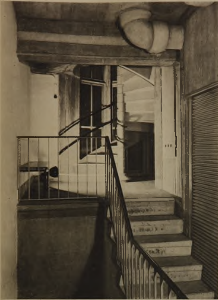
Antritt der Wendeltreppe auf der Höhe des Wasserbehälters
