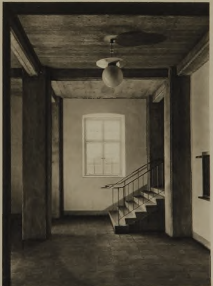
Erdgeschoßhalle mit Treppenantritt
