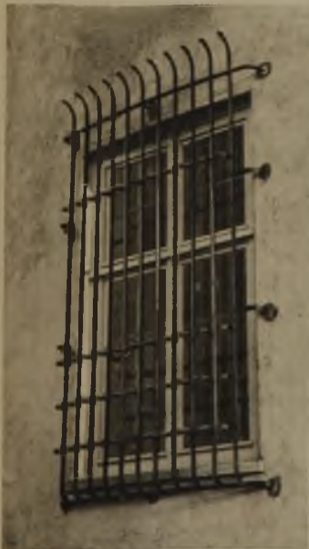
Fenster im Erdgeschoß
