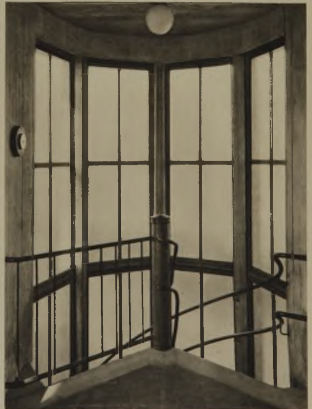
Austritt der Wendeltreppe auf die Plattform über dem Wasserbehälter
