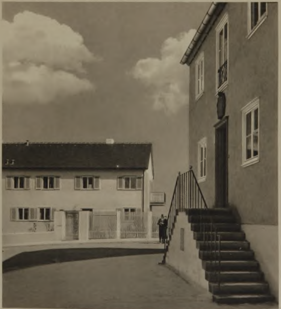
Eingang zu Haus 1. Im Hintergrund Haus 25 Aufnahmen Reg.-Baumstr. Fels, Stuttgart-Degerloch
