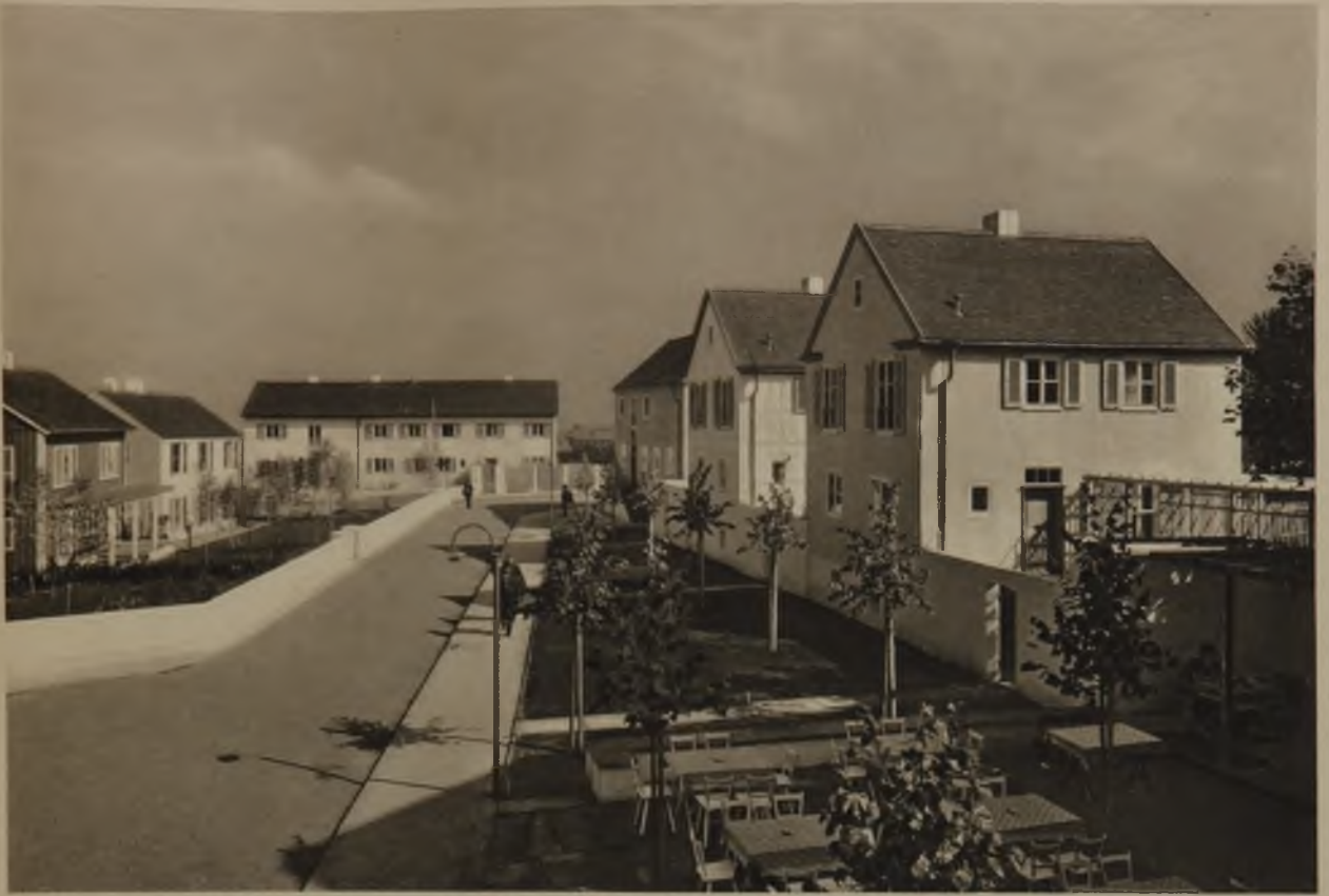
Blick durch die Hermann-Plesser-Straße von West nach Ost. Aufnahme Fels
