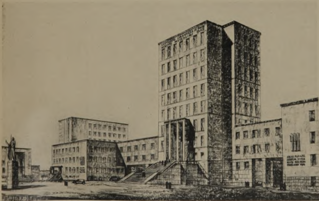
9 Blick auf das Rektoratsgebäude mit Bücherspeicherturm der Bibliothek. Arch. Piacentini. Nach links Anschluß an die juristische, rechts an philologische Fakultät
