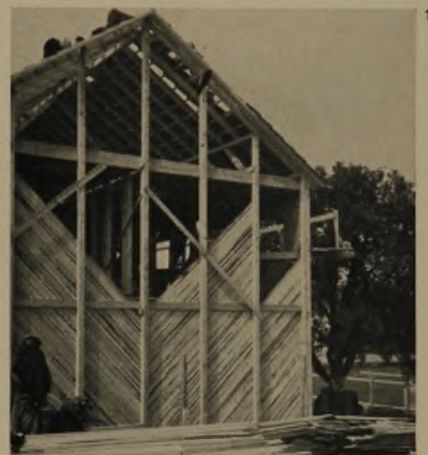
Fachwerk von Haus Nr. 10. Pfosten in ganzer Höhe durchlaufend Diagonal-Verschalung zur Aussteifung
