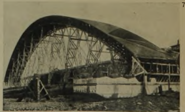
Lehrgerüst der Elorn-Brücke bei Plongastel von 170 m Spw. (Engineering 1929). Mit Drahtstiften als Holzverbindungsmitel
