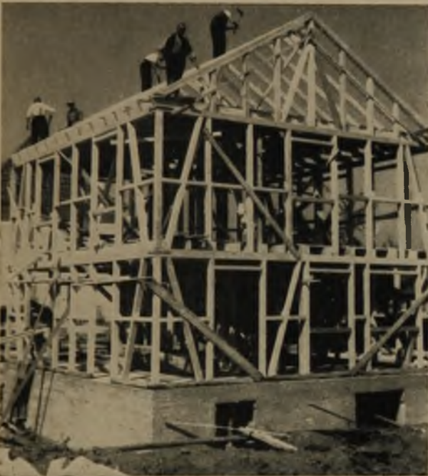
Fachwerk von Haus Nr. 5. Pfosten über Pfosten stehend Balken auf Rahmen aufgelagert
