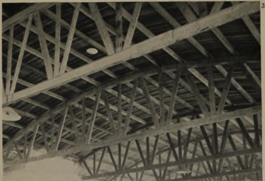
2 u. 3 Bretter-Fachwerksbinder von 18,90 m Spw., 5 m Binderentfernung
