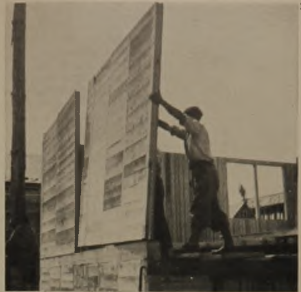
Wandausbildung am Haus Nr. 18. (Vgl. Abb. 23) Tafelbauweise mit stockwerksweisem Aufbau
