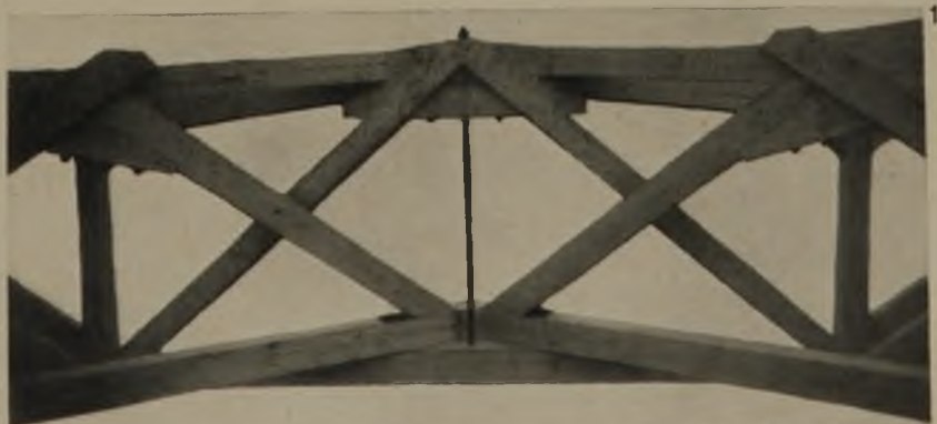
Bild des Schrägbinder-Auflagers auf Mitte des Binders II
