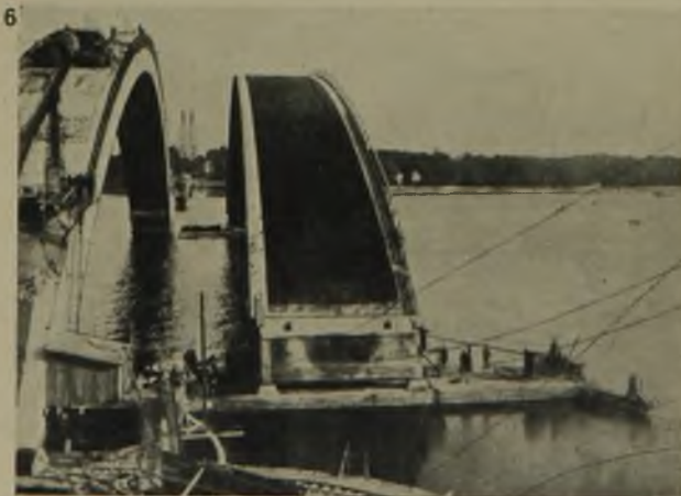
Lehrgerüst der Elorn-Brücke bei Plongastel von 170 m Spw. (Engineering 1929). Mit Drahtstiften als Holzverbindungsmitel
