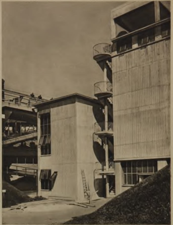
Oben: Die Treppe zwischen Maschinenhaus und Bunkergebäude. Unten: Die Trichter im Bunkergebäude
