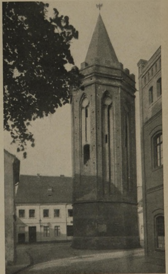
Abb. 20. Mühlentorturm in Brandenburg von der Domseite.
