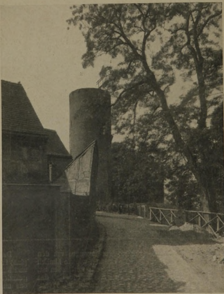
Abb. 1. Plauer Torturm. (Alter Zustand.)
