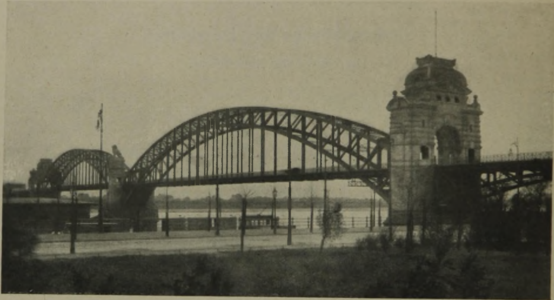
Abb. 3. Brücke vor dem Umbau. (Erbaut 1896—1898.)
