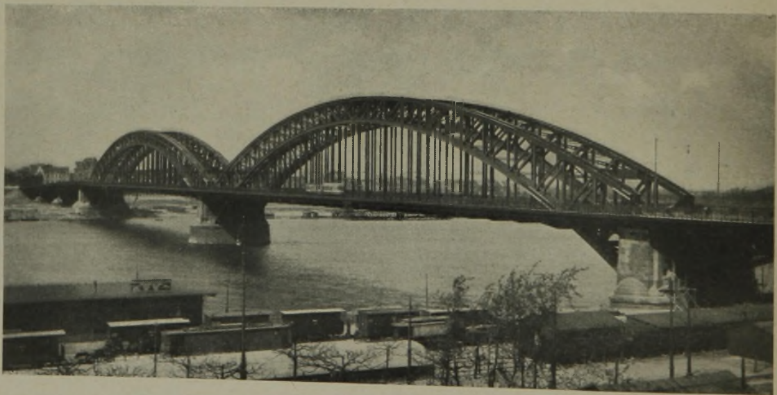
Abb. 4. Brücke nach dem Umbau 1925—1926. (Phot. Julius Söhn, Düsseldorf.)
