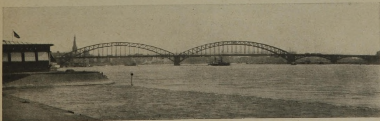
Abb. 1 u. 2. Oben alter Zustand, unten neuer Zustand der Brücke. (Phot. Julius Söhn, Düsseldorf.)
