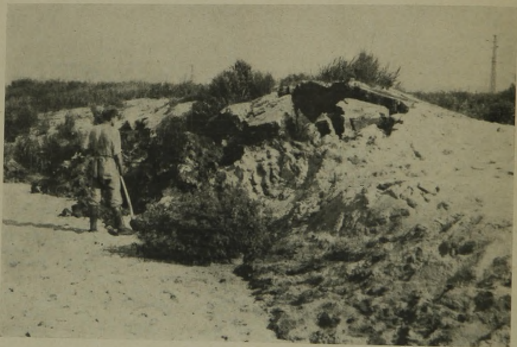
Abb. 13. Mooraufreibung infolge Rampenschüttung für die Marschbahn.
