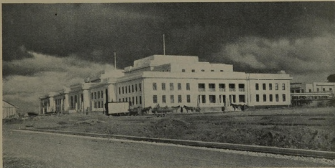
Abb. 1. Parlamentsgebäude. Blick auf die Hauptfront.
