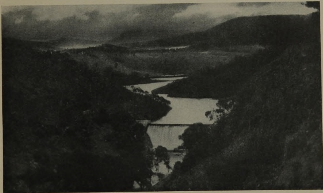
Abb. 9. Talsperre für die Wasserversorgung vom Cotterfluß.
