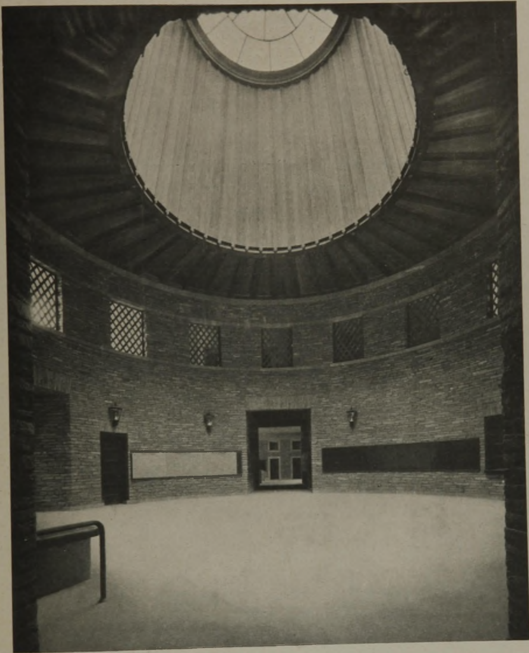
Abb. 24. Innenraum der Schalterhalle des Empfangsgebäudes Enge.
