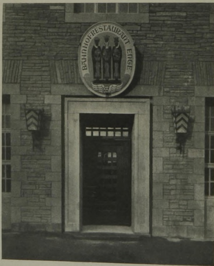
Empfangsgebäude Enge in Zürich. Arch. Gebrüder Pfister, Zürich.
