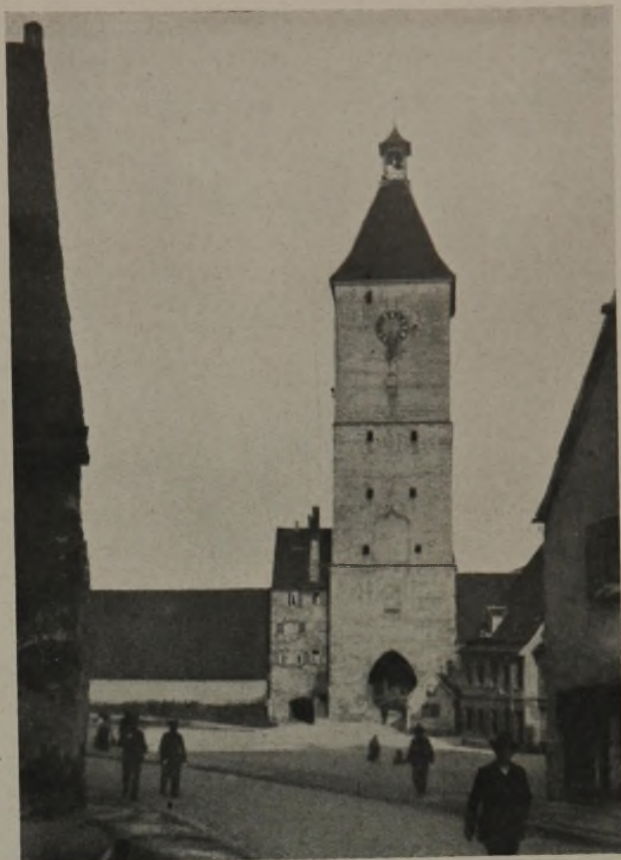
Abb. 5. Blick auf das freigelegte Gänstor. (Blick 2.)
