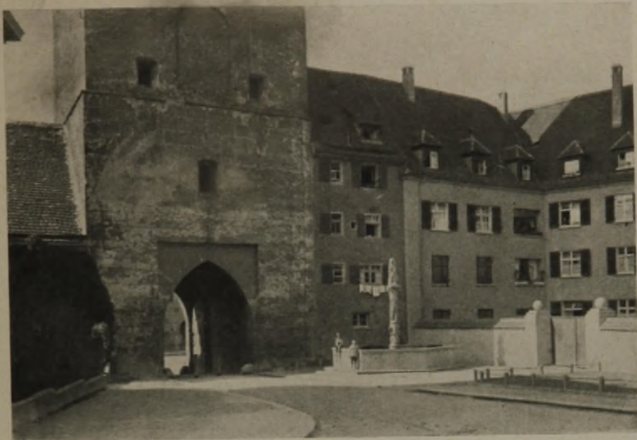
Abb. 10. Der Stadteingang durch das Gänstor nach dem Einbau. (Blick 5.)
