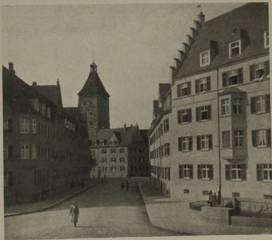
Abb. 11. Blick von der neuen Donaubrücke zum Gänstorturm. (Blick 6.)
