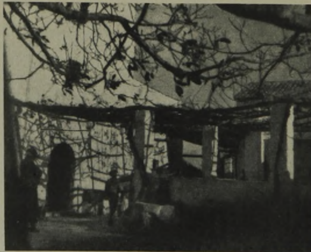
ABB. 7. GROSSES WASSERBECKEN, ÄUSSERES
