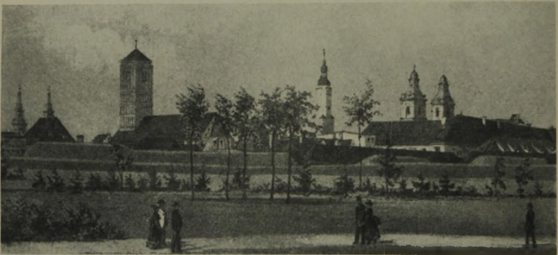
ALTES STADTBILD MIT DEM EHEM. FESTUNGSGRABEN
