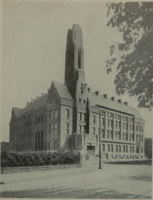
ABB. 14. BÜROGEBÄUDE „PETROLEA“ Arch. De Roos v. Overeynder
