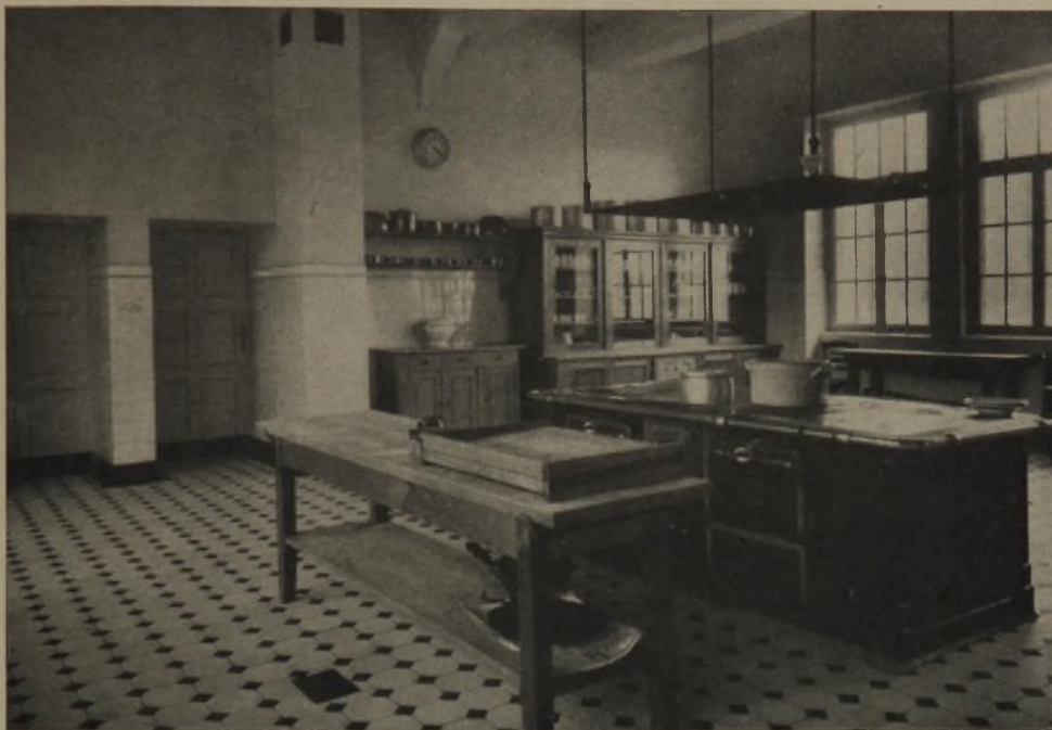
Abb. 12. Blick in die Restaurationsküche.
