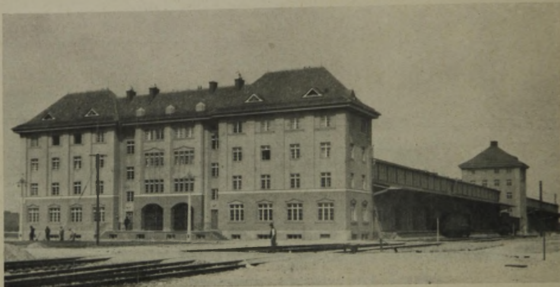
Abb. 11. Lagerhallen I u. II mit Bürogebäude (Landseite) am Hafenbecken III. Architekt: Mag.-Baurat Sch ä ff, Königsberg i. Pr.
