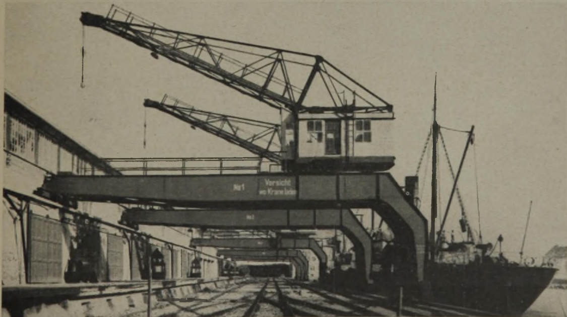
Abb. 15. Lagerhallen mit Anschlußgleis und Kranbahn (Wasserseite) am Hafenbecken III. Architekt: Mag.-Baurat Schöff, Königsberg i. Pr.
