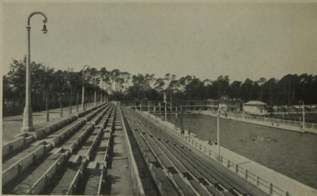
Abb. 9. Blick auf das Sportschwimmbecken.
