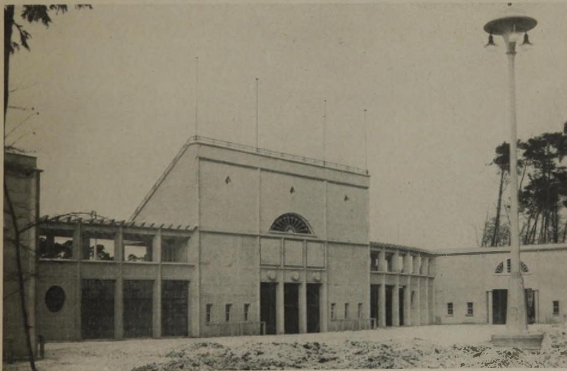
Abb. 1. Haupteingang zur Radsportbahn. (Vergl. Plan Abb. 6.) (Aufnahme Dr. P. Wolf, Frankfurt a. M.)
