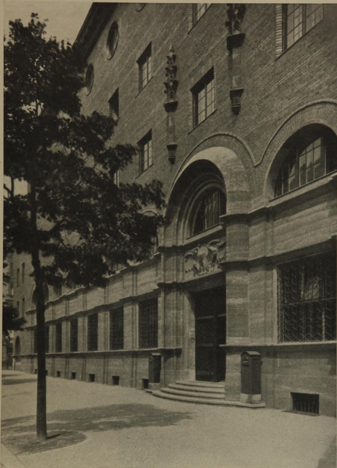
Abb. 10. Haupteingang an der Geisbergstraße. Das Postamt W 30 in der Geisbergstraße in Berlin. Architekt: Oberpostbaurat W. Hoffmann, Berlin.
