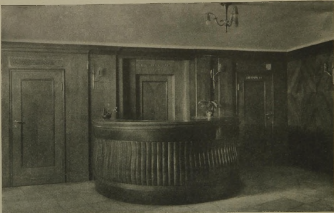
Abb. 10. Untergeschoß. Eingang zu den Toiletten und Verkaufstisch. Kirschbaumholz poliert, Fußboden Solenhofener Platten.
