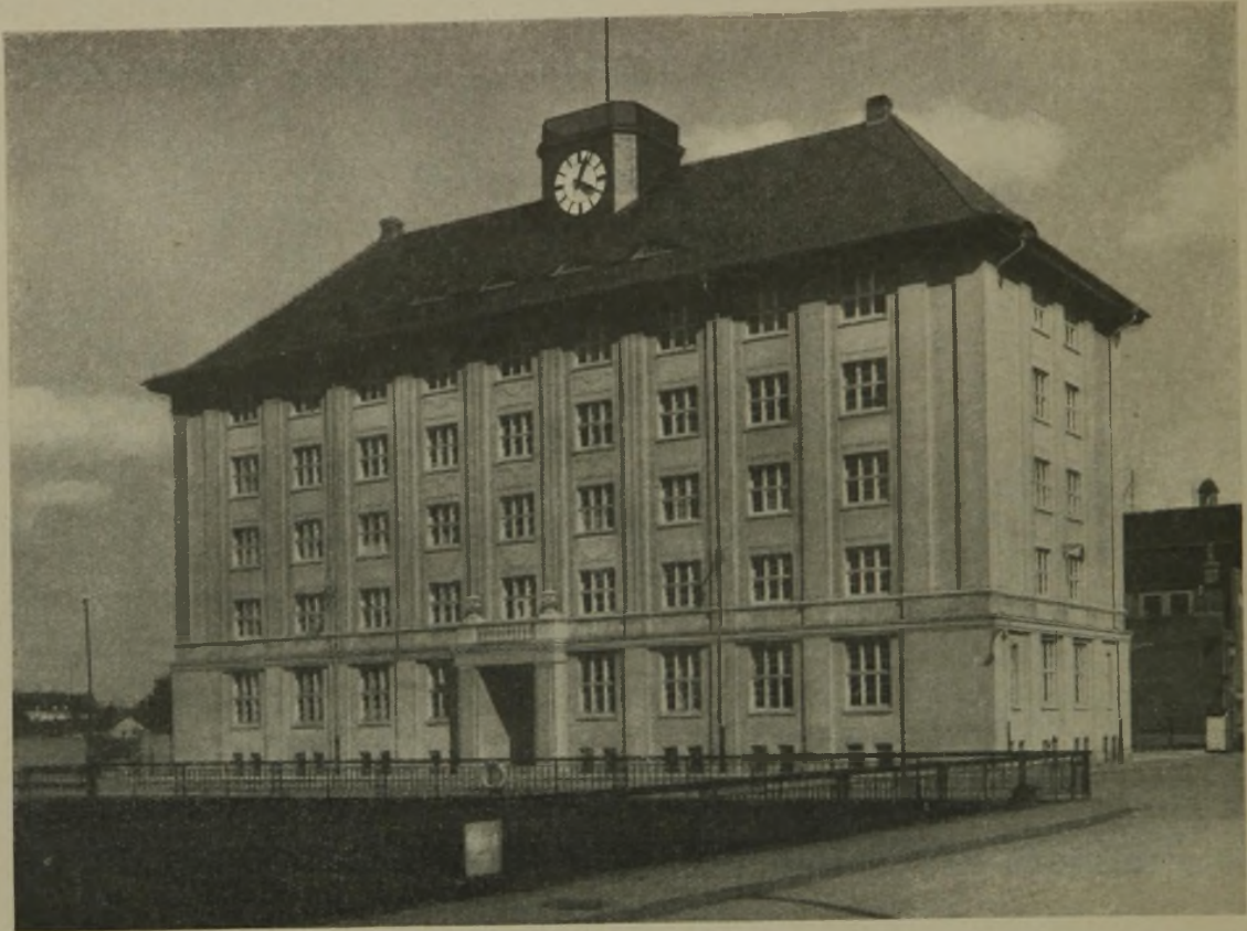
Abb. 12. Neubau für die Schutzpolizei in Bremen am Hafen II.
