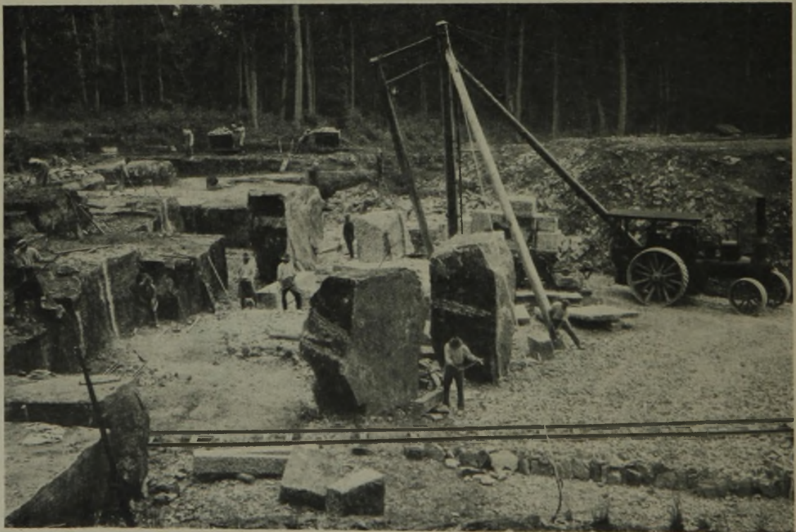
Abb. 2. Muschelkalksteinbruch „Waldruch“ Kleinrinderfeld bei Würzburg.
