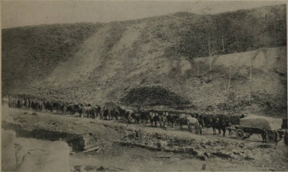
Abb. 3. Abfuhr eines rd. 25 cbm. großen Steinblocks für das Reichstagsgebäude aus dem Steinbruch Alt-Warthau in Schlesien.
