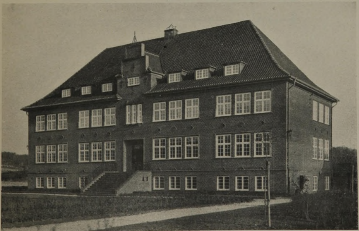
Abb. 1. Straßenansicht von Südwesten.
