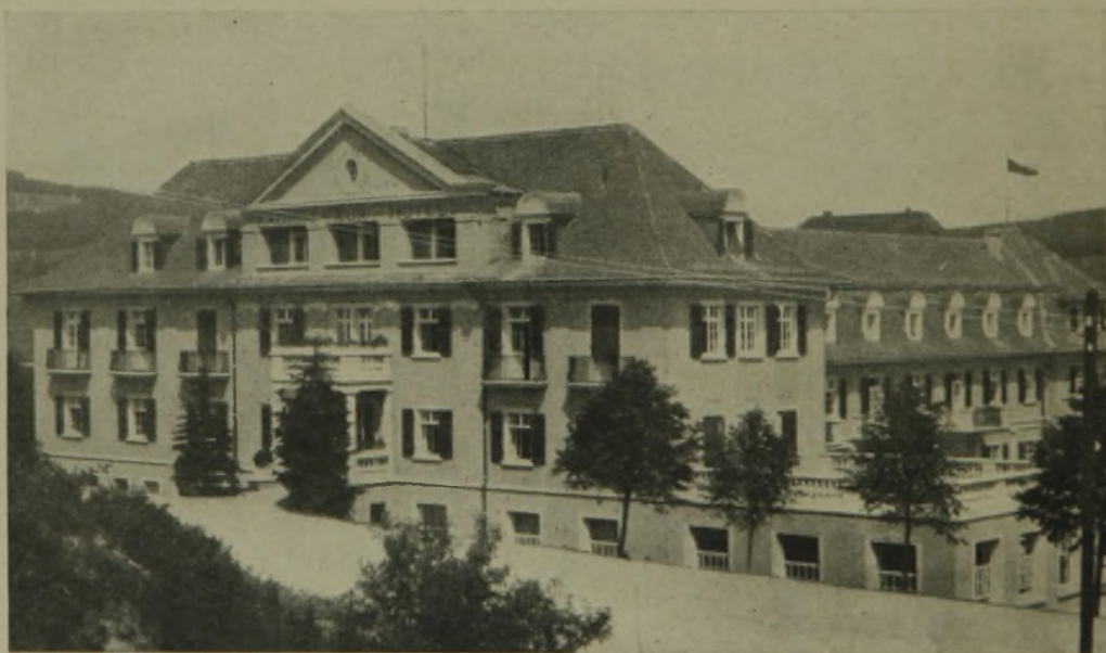
Abb. 6. Hauptansicht an der Röthenbachstraße.
