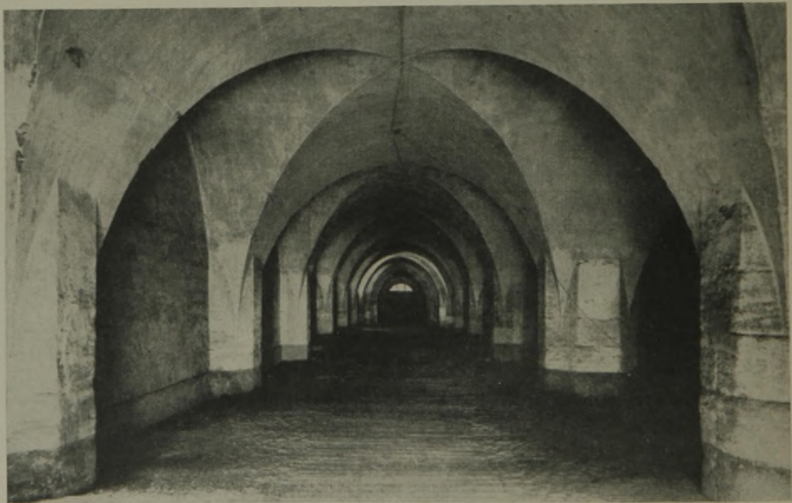
Abb. 2 u. 3. Erstes Obergeschoß und Erdgeschoß der „Mauthalle“ in Nürnberg, erbaut 1498—1502. Aufnahmen: Städtisches Hochbauamt, Nürnberg.
