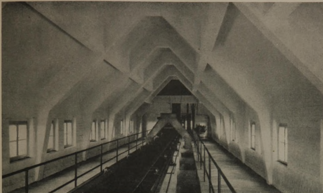
Abb. 4 (oben). Kesselhausbunker in Leipzig-Plagwitz, erbaut 1922 für die Sächsische Wollgarn- fabrik A. G. vorm. Tittel und Krüger.
