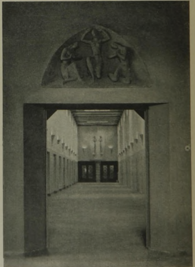
Abb. 14. Betriebsgang. Blick v. Aufnahmeraum.
