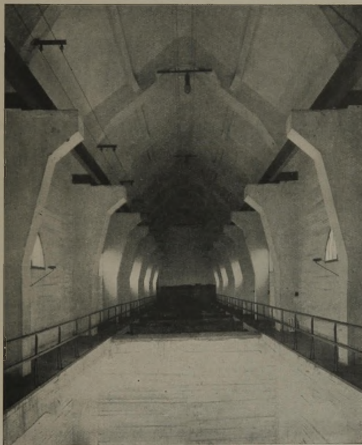
Abb. 5 (links). Kesselhausbunker in Kassel, erbaut 1921 für die Maschinenfabrik Henschel und Sohn.
