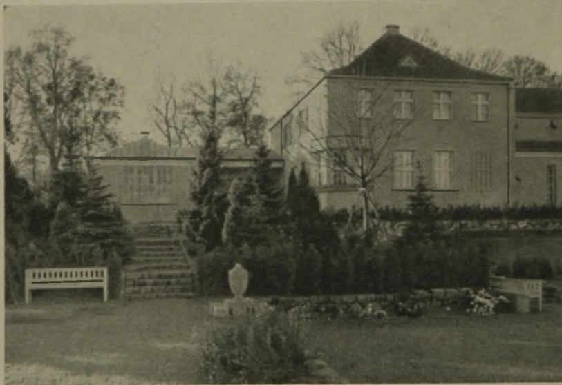
Abb. 17. Verwaltungsgebäude mit Sezierhaus.
