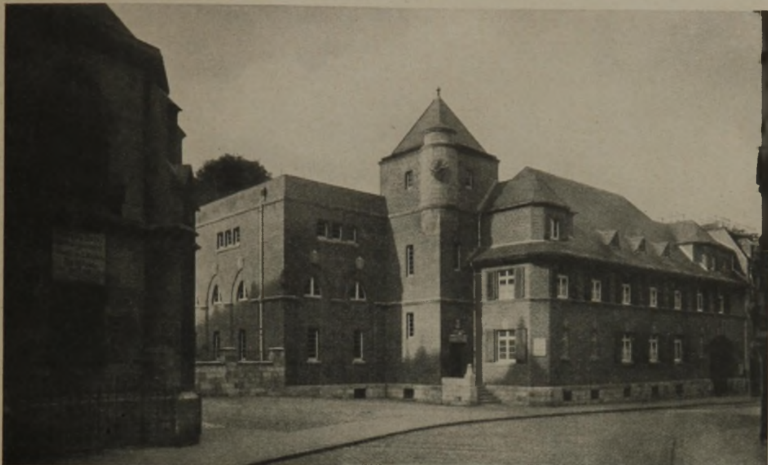
Abb. 10. Umformerwerk Minoriten- Ecke Großkölnstraße. Erbaut 1925/26.
