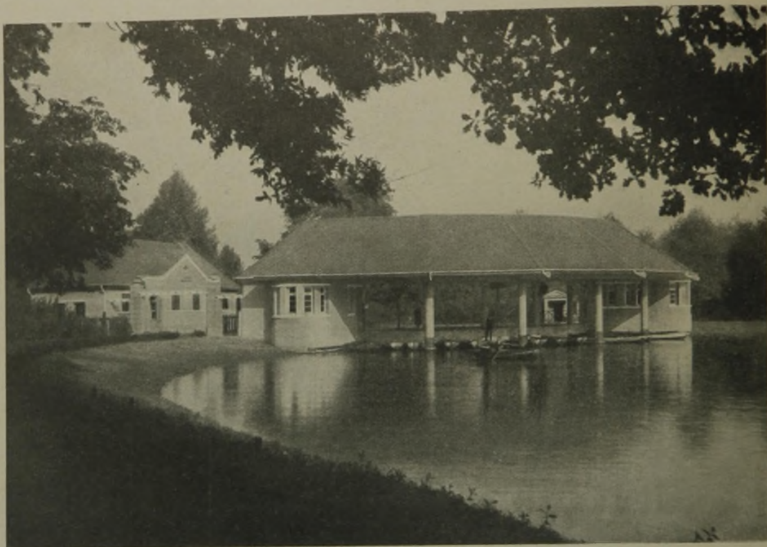
Abb. 8. Neubauten im Kaiser-Friedrich-Park zu Aachen. Erbaut 1922/24. (Links Kassen- und Wärterhaus zum Schwimmbad, rechts Kahnhalle.)
