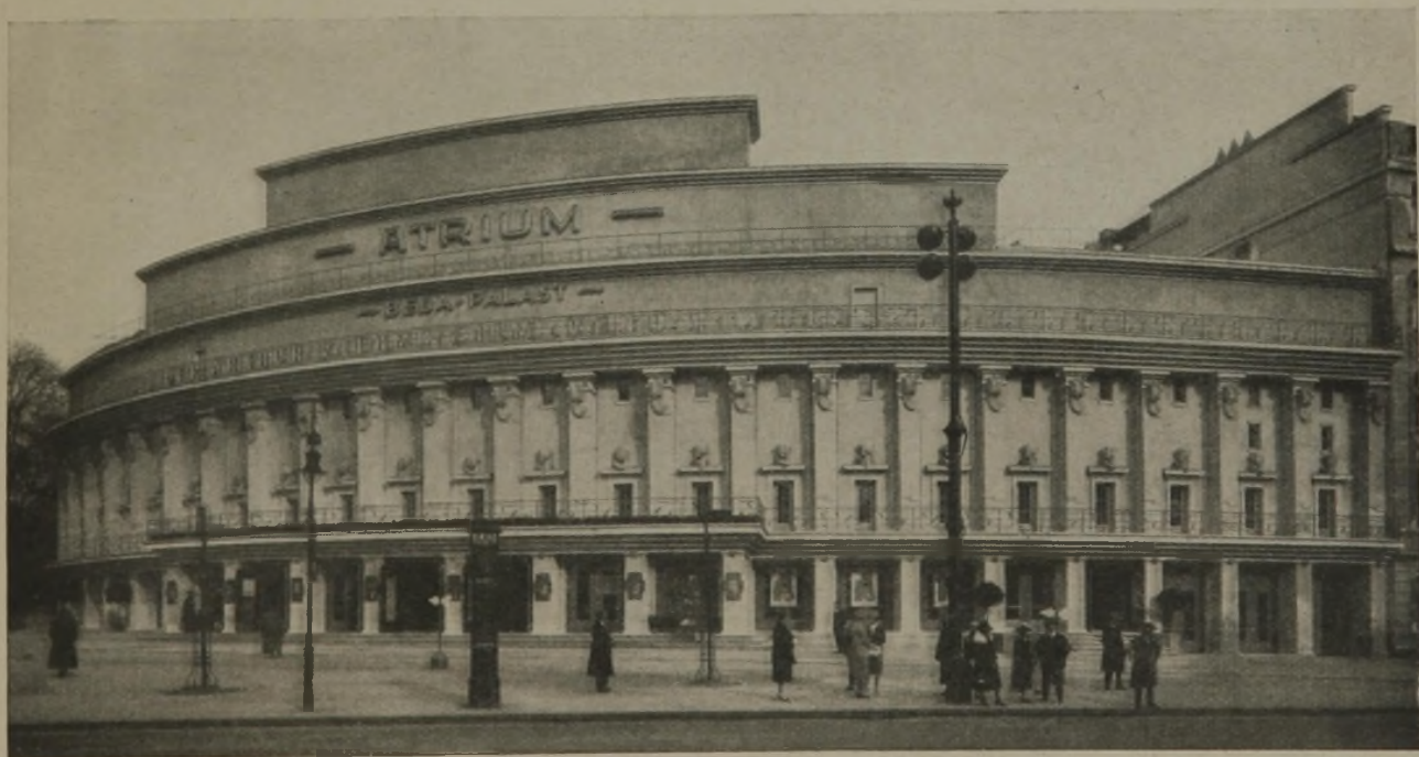
Abb. 1. Hauptansicht von der Kaiser-Allee. (Alle phot. Aufnahmen von Franz Linkhorst, Berlin-Halensee.)
