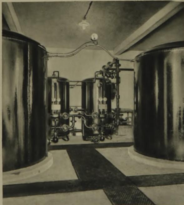
Oben eines der Treibhäuser für Frühgemüse u. ä. (Länge 50 m). Unten Druckkessel und Enteisungsanlage im unterirdischen Maschinenhaus der Wasser-, Licht- und Kraftstromversorgung
