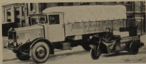
5-Tonnen-Lastkraftwagen mit Wirbelkammer-Dieselmotor Vomag Betriebs-A.-G., Plauen i. V.
