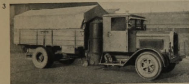
5-Tonnen-Lastkraftwagen mit Imbert-Generatoren. Henschel & Sohn, Kassel, u. Imbert-Gas-Generatoren G. m. b. H., Berlin
