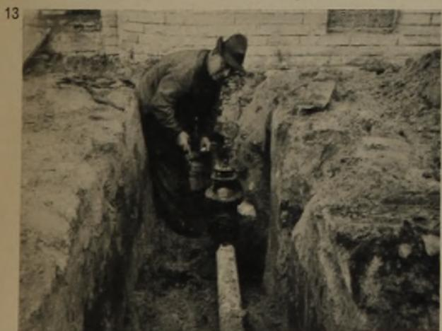
**13 Fertigmachen eines Hausanschlusses** (Vorn Absperr-Vorrichtung). Hausanschlußleitung an der Mauerdurchführung mit Steinzeugrohr umgeben, das eingemauert. Zwischenraum zwischen Gasrohr und Steinzeugrohr mit plastischer Masse ausgefüllt. Dadurch dichter Abschluß, Schutz gegen Korrosion, keine Übertragung von Erschütterungen, also Ausschluß von Bruchgefahr
