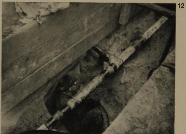
**12 Verbindung von 2 Rohrenden untereinander und mit Hausabzweig (Über-Kopf-Schweißen).** Die an den Schweißstellen entfernte Rohrinsolierung muß nach Druckprobe wieder hergestellt werden
