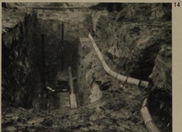
**14 Querschnitt durch den Graben mit Zweigleitungen.** Links Wasserleitung mit Absperrvorrichtung, Mitte geschweißter Abzweig der Gasleitung, dahinter Steigerohr zur Entleerung des Kondenswassertopfes (Gasleitung von Mitte nach beiden Seiten steigend, an der tiefsten Stelle Wassertopf). Rechts Kabel mit Kabelsteinen abgedeckt
