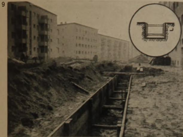
**9 Fertig ausgesteifter erster Graben.** Raum für Graben, Rüstzeug, ausgehobenen Boden ist frei zu lassen, daher Verbot in Abstand von ca. 9 m vor Hausflucht etwas zu lagern (je nach den örtlichen Verhältnissen)
