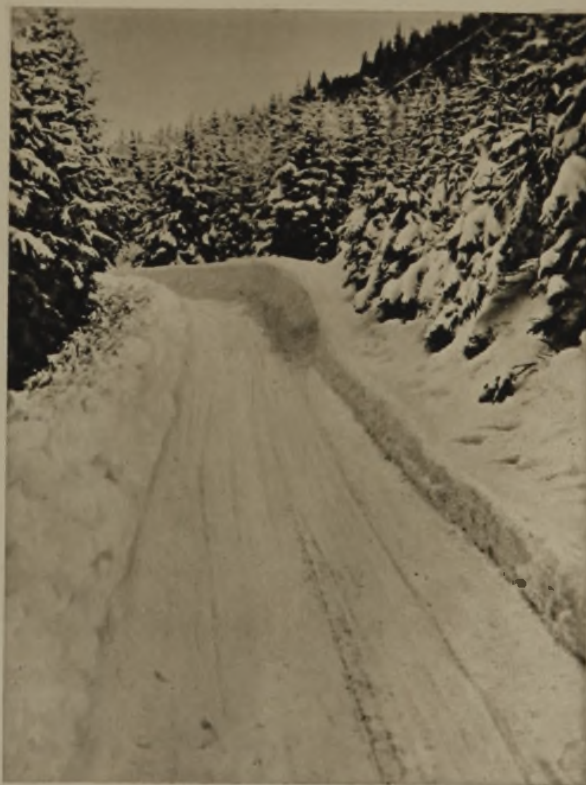
Dieses Bild zeigt den Fall a nebenstehender Skizze: Böschung liegt zu weit zurück
