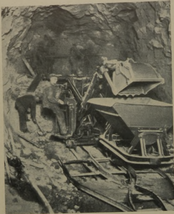
3 Butler-Schauffellader im Stollen
