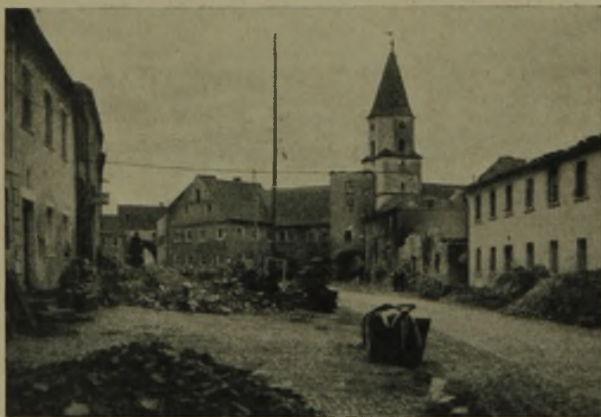
Hauptstraße nach dem Brande
