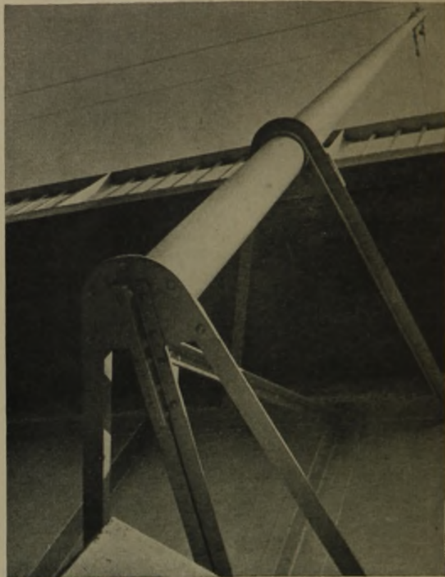
16 Blick vom Pfeiler aufwärts
