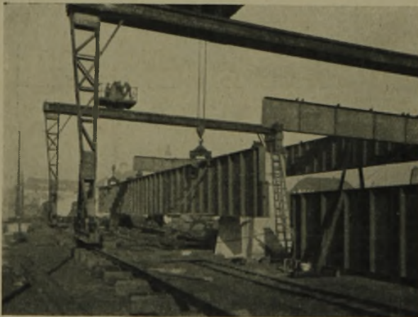
7 Montage der Hauptträger
