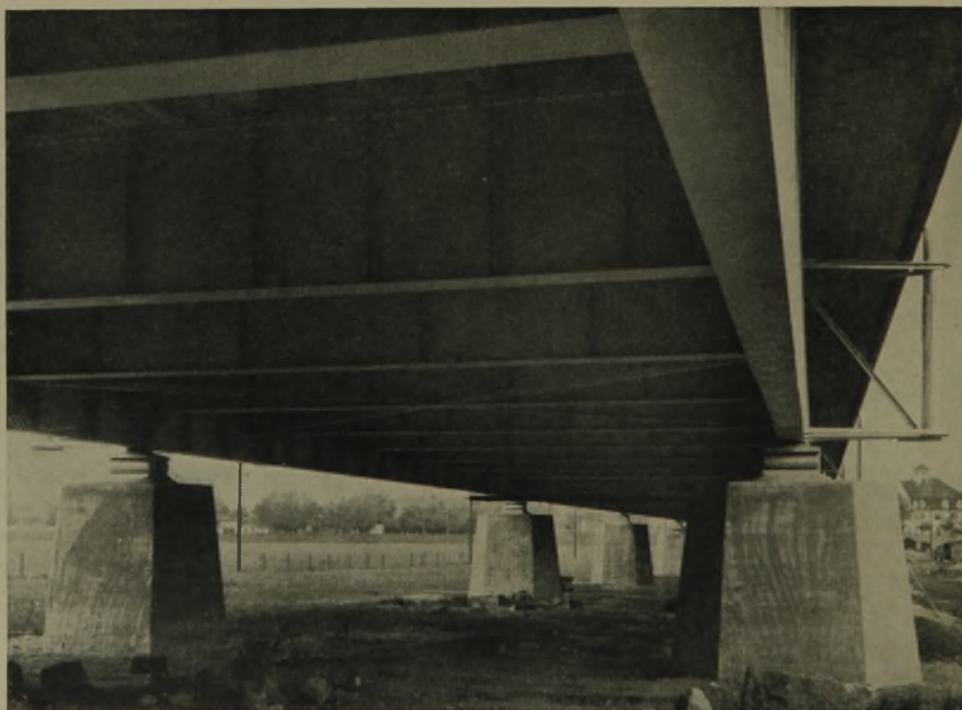
17 Untersicht unter die Brücke
