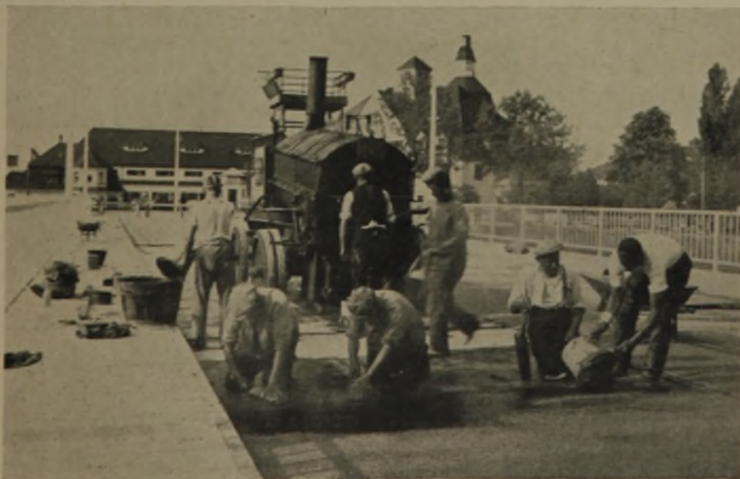
12 Abdichtung der Fahrbahn mit Bitumpappe
