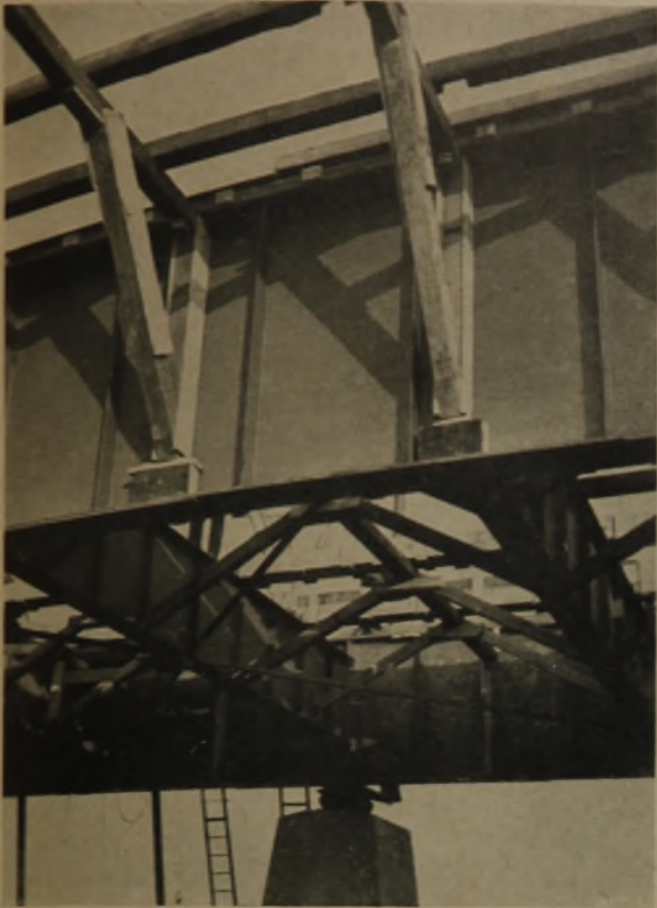
10 u. 11 Schalung und Eiseneinlagen der Fahrbahnplatte
