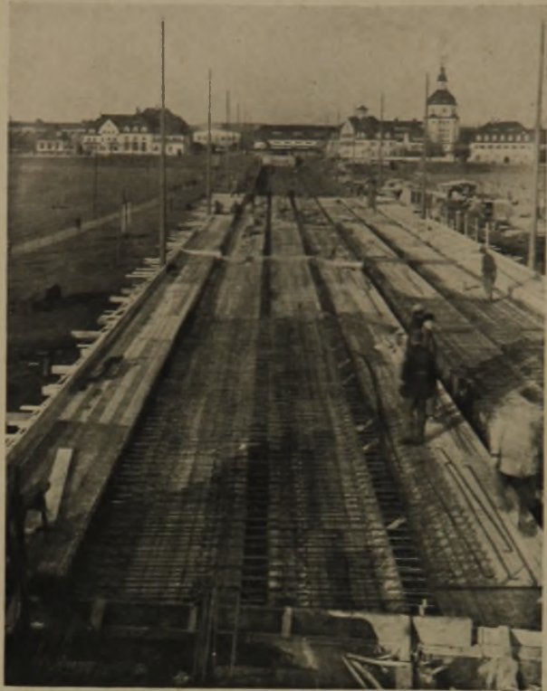
10 u. 11 Schalung und Eiseneinlagen der Fahrbahnplatte
