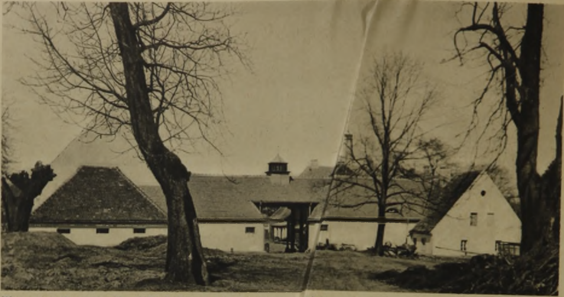
Wagen- und Maschinenhalle mit Toreinfahrt von der Feldseite aus gesehen
