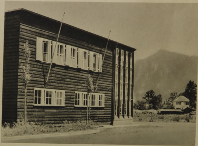
Kraftwagenhalle in Füssen
