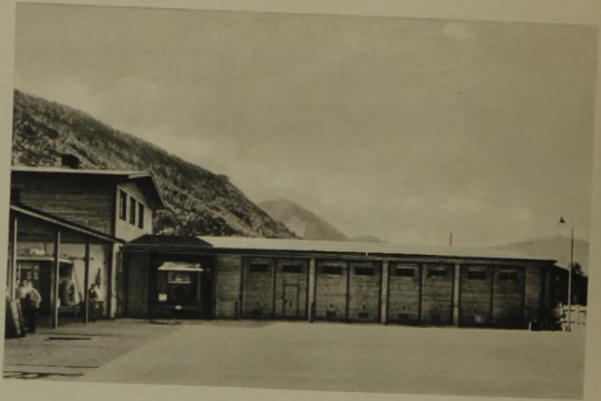
Blick in den Hof mit Kraftwagenhalle
