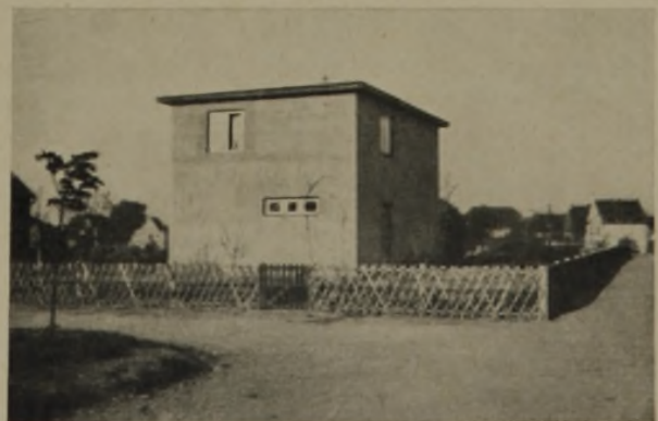
Ansicht von der Straße. 1. Bauabschnitt
