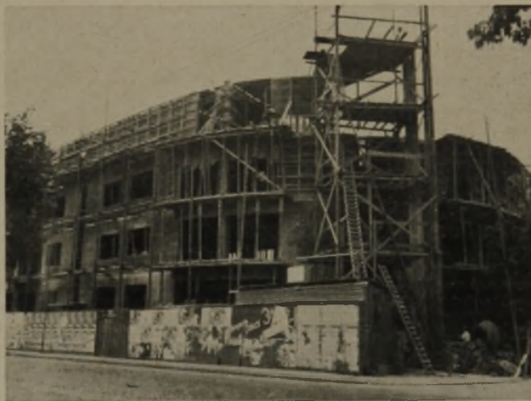
6 Beispiel der Anwendung einer Schalung zur Formgebung des Leichtbetons auf der Baustelle
