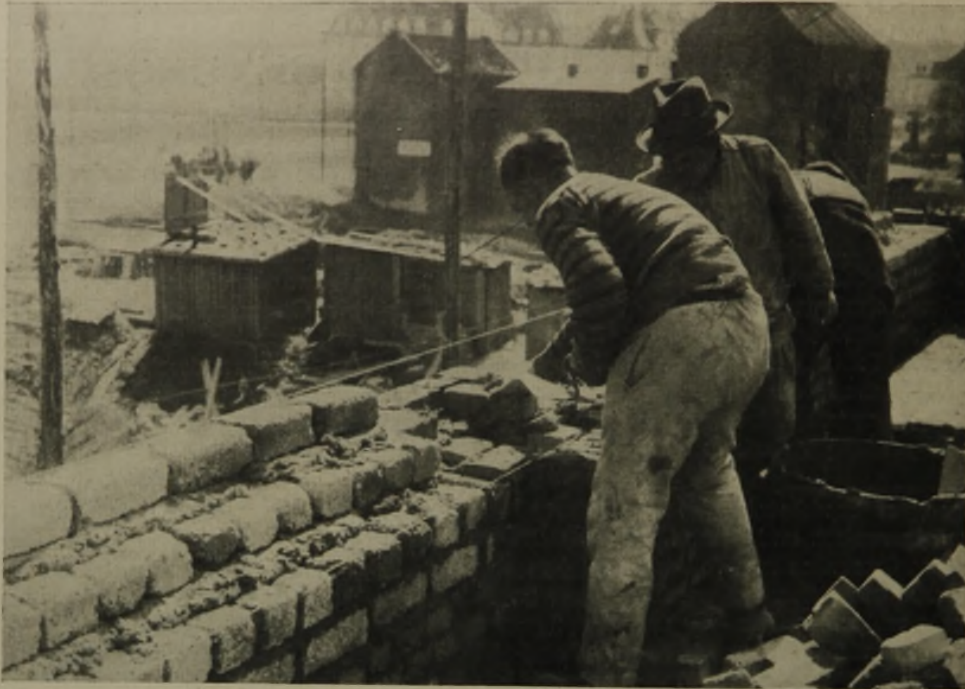
Beispiel einer guten Wand (20 cm stark aus Bims-Spezialsteinen). Vorteile: warm, trocken, atmend.
