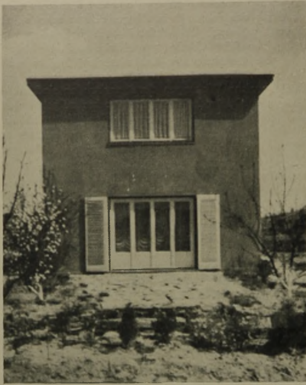
Ansicht der Westseite
