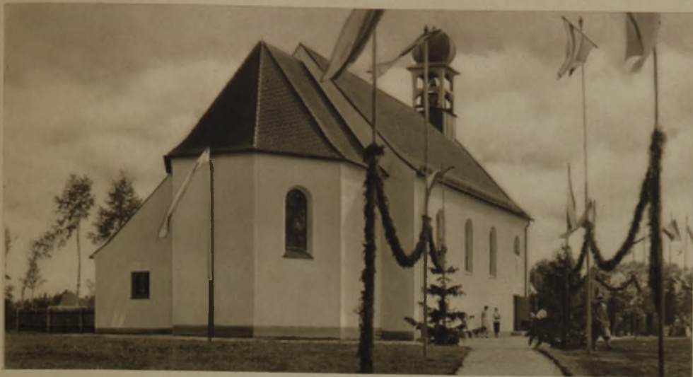
Blick gegen den Chor. Einfacher Putzbau aus Backstein und Holz. Dachreiter: Holz mit kupfergedeckter Zwiebel. Dachdeckung: rote Biberschwänze
