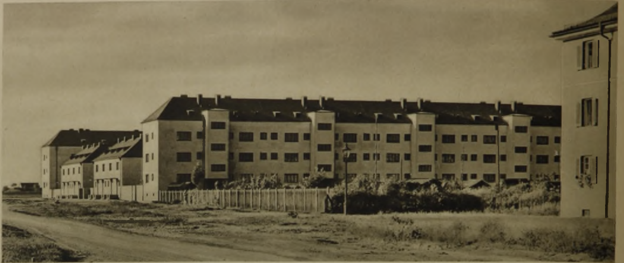
3 Fassaden am Alten Postweg und Robert-Gerber-Straße
