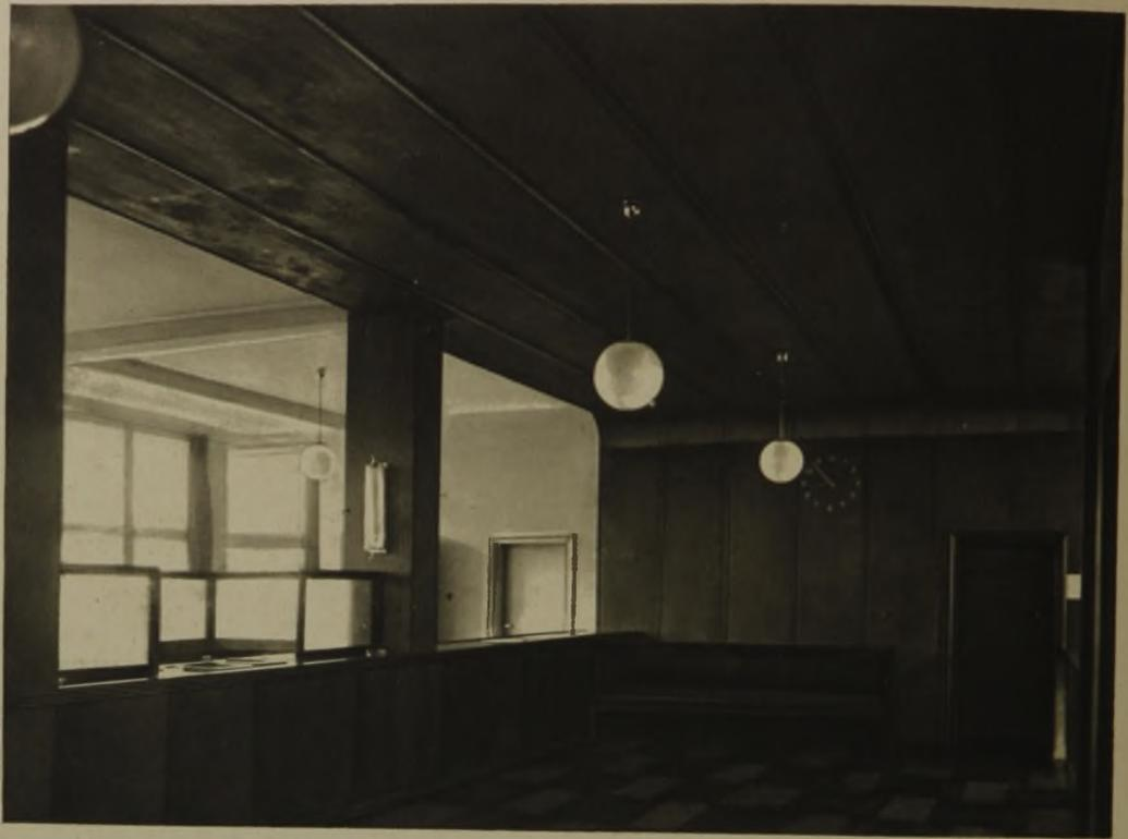
Blick in den Kundenraum. Wände und Decke in dunkler Eichenholztäfelung (Architekt wollte hellen Stuck). Fußboden Fliesenlinoleum. Beleuchtung provisorisch. Soll nach Absicht des Architekten später durch Soffitten erfolgen
