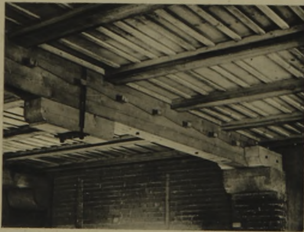
Endauflager der Unterzüge der Decke
