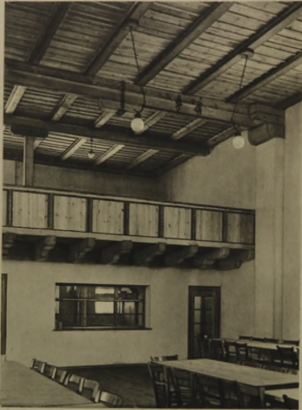
Blick gegen die Empore und unter die Holzbalkendecke
