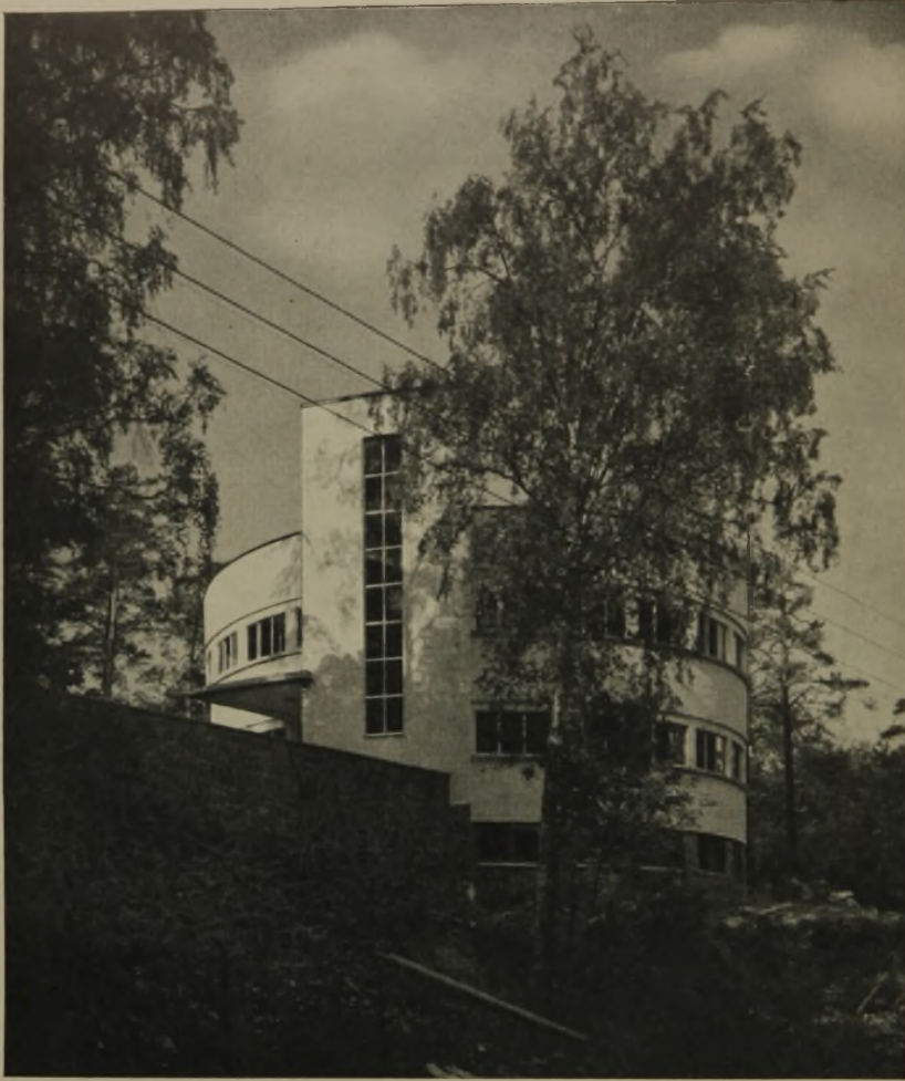
Bild des Gesamtbaus mit Blick gegen das Treppenhaus
