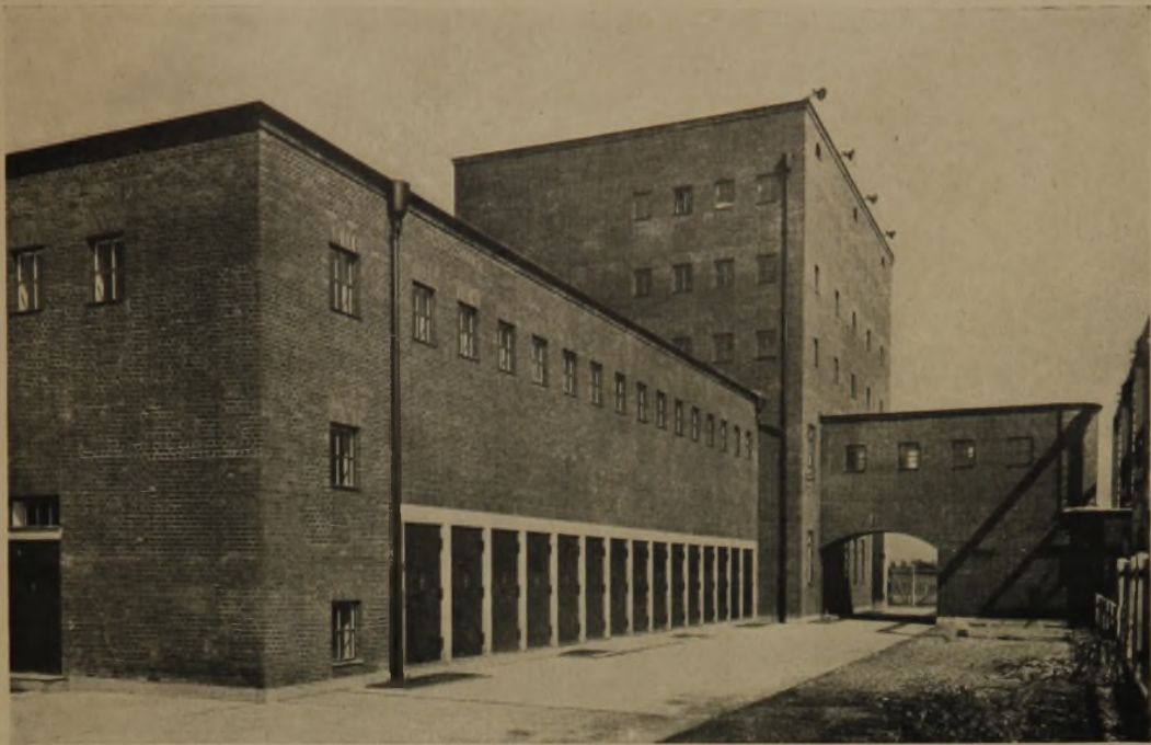
Uppenbornkraftwerk bei Moosburg und KV-Anlage mit Ölschalterzellen, Steuerhaus und Übergang zum Bedienungsang 60 KV-Anlage
