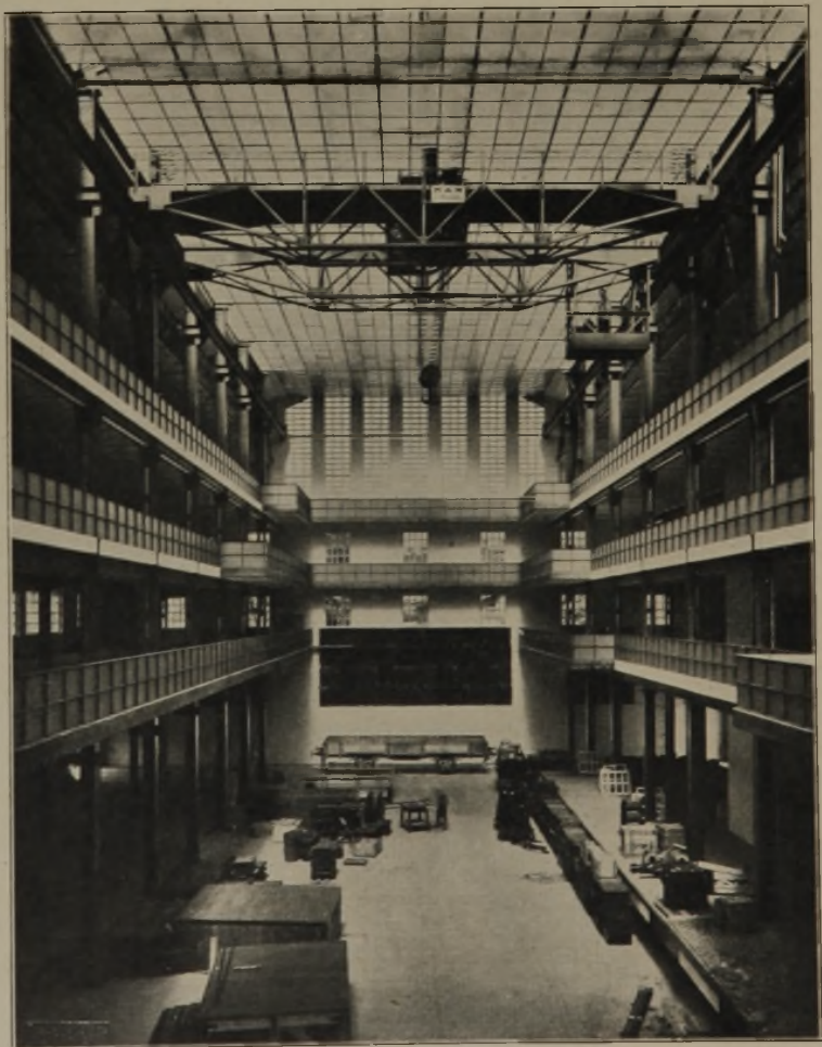
Lagerhalle der Städt. Elektrizitäts-Werke a. d. Isartalstraße
