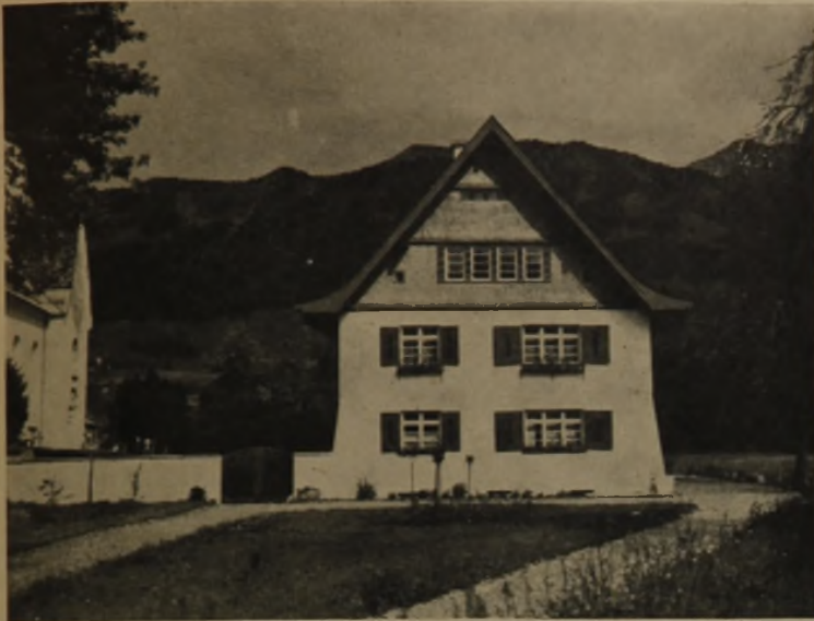
Ansicht von der Dorfstraße aus
