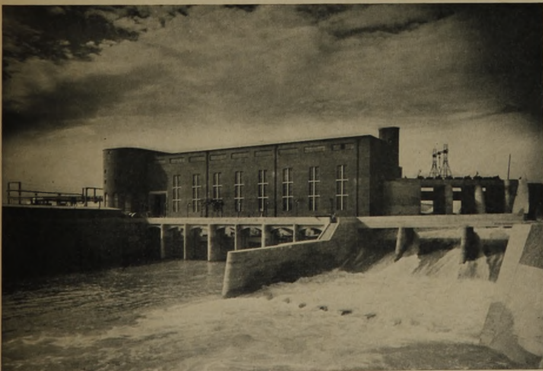
Uppenbornkraftwerk bei Moosburg. Gesamtansicht (Unterwasserseite)
