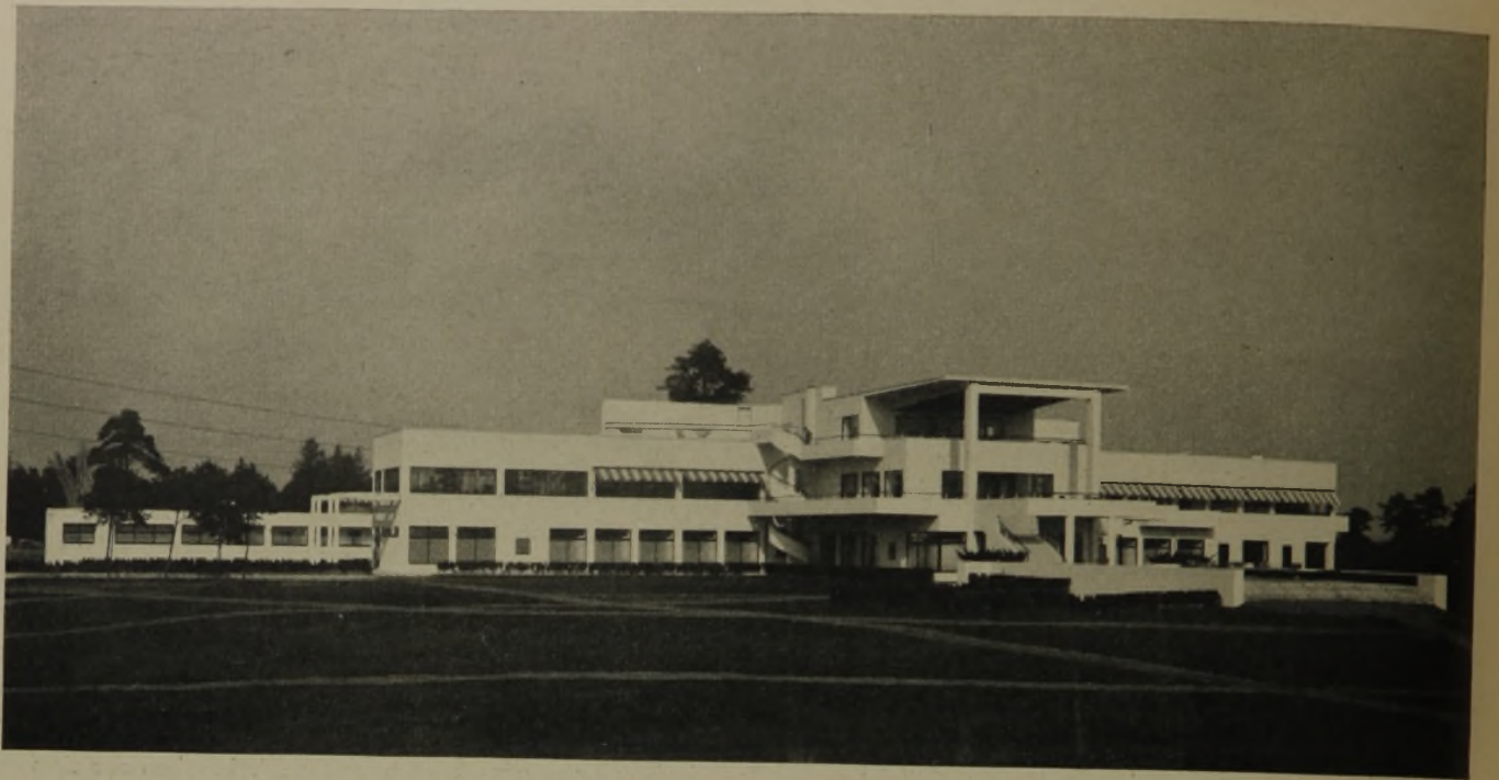
Gesamtansicht von der Seite des Speisesaales
