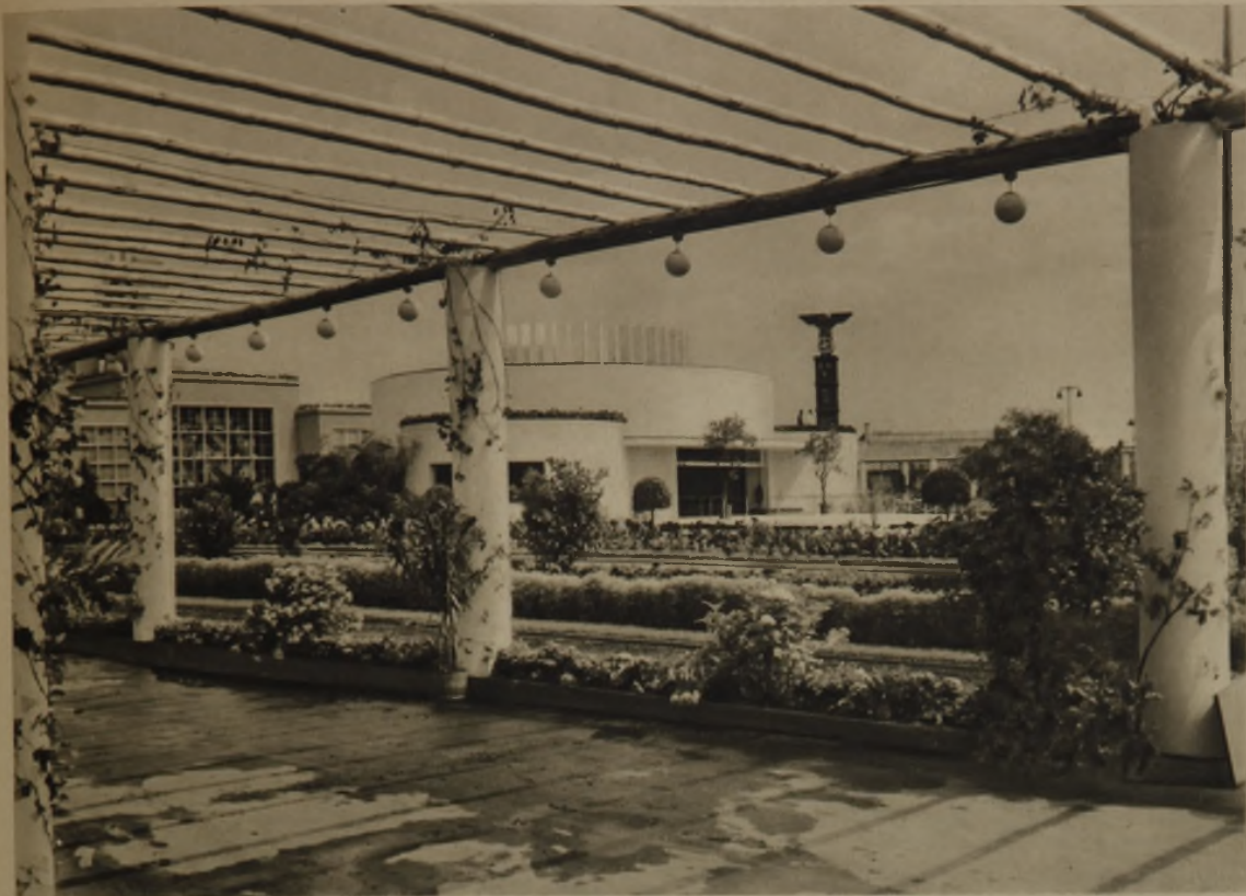
Haus „Ring der Frauen“ (ursprünglicher Entwurf von Peter Behrens) als Mittelpunkt einer großzügigen Gartenanlage, die von einer 300 m langen Pergola umschlossen wird. Links gegen den Haupteingang zu wird dieser Gartenteil abgeschlossen vom Hause der Deutschen Arbeitsfront. Rechts vom Hause „Ring der Frauen“ aufragend der außerhalb des Ausstellungsgeländes stehende Turm der Arbeit
