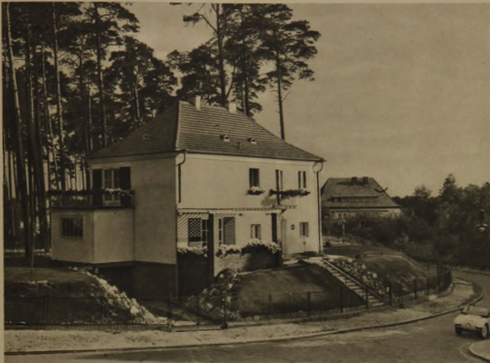
Gesamtbild von der Straße
