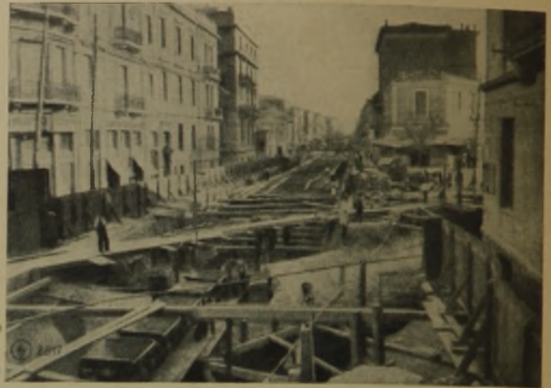
11 Düker in der Marnstraße im Bau
