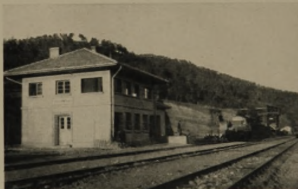
8 Beispiel eines Empfangsgebäudes
