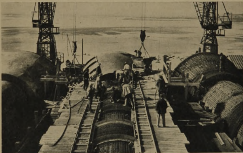
2 Herstellung der Eisenbeton- Hohl Pfeiler
