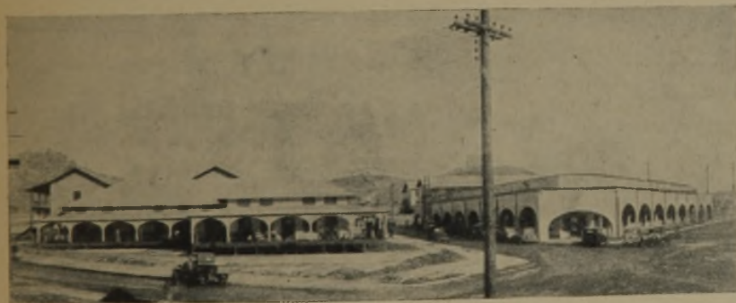
10 Gebäude mit Speise-, Lese- usw. Salon für die Arbeiter (links)
