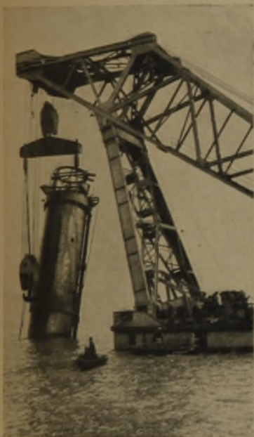
4 Versetzen der Pfeiler m. Kran von 300 t Tragkraft, 3,7 m innerer Durchmesser, Höhe 26,5 m, Gewicht 280 t
