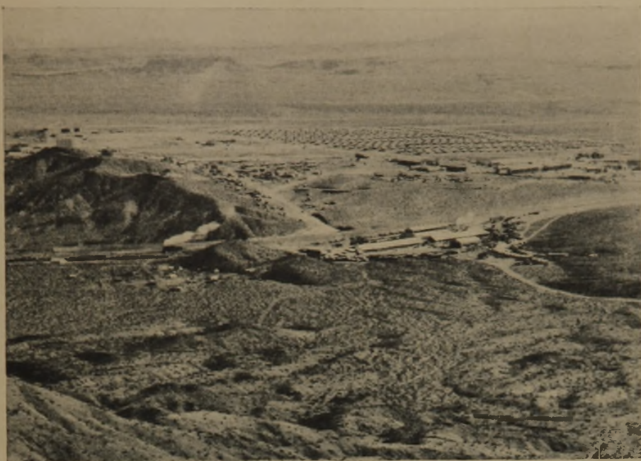
2 Die Umgegend von Boulder City mit den Arbeiterbaracken usw. im 2. Bausommer
