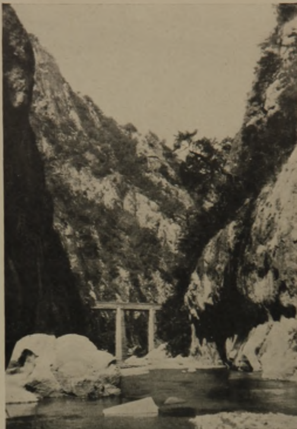
6 Eisenbetonbrücke in der Kile-Schlucht
