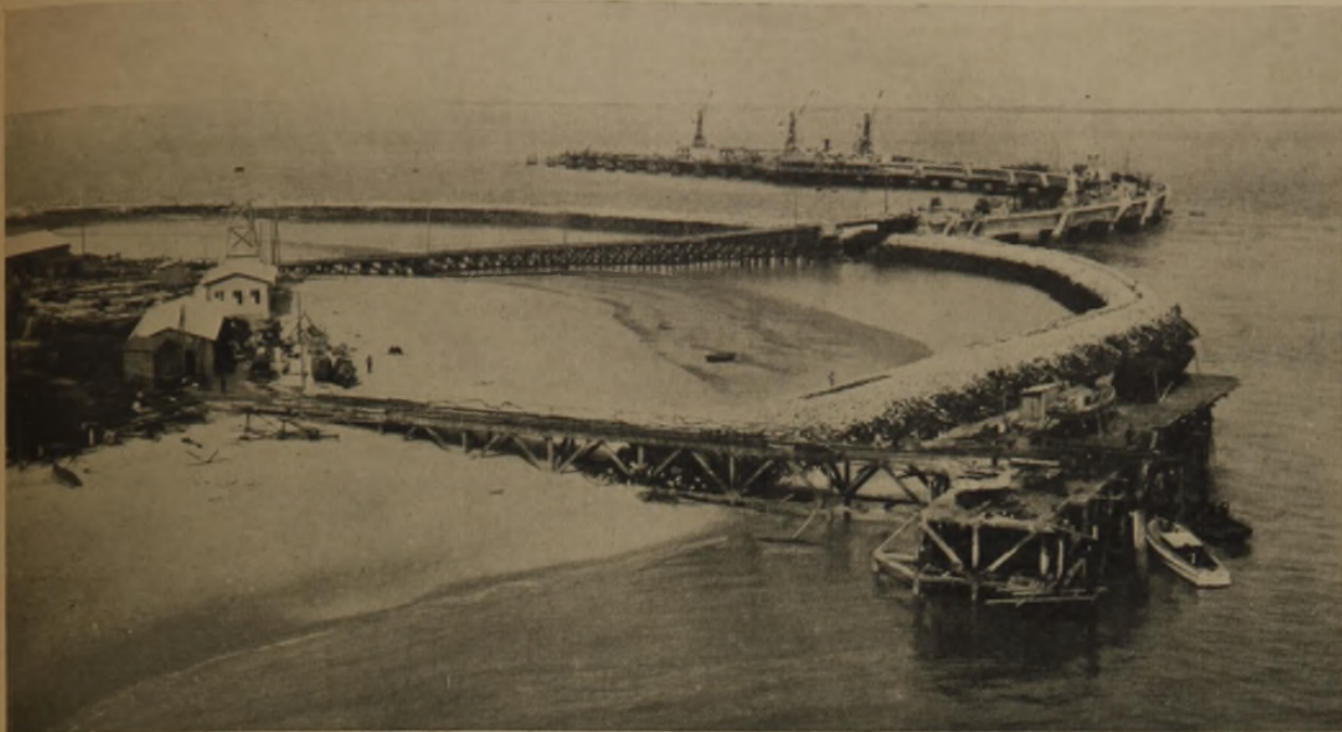
1 Gesamtbild der Baustelle. Der an Land anschließende halbkreisförmige Steindamm wird mit Baggerboden hinterfüllt
