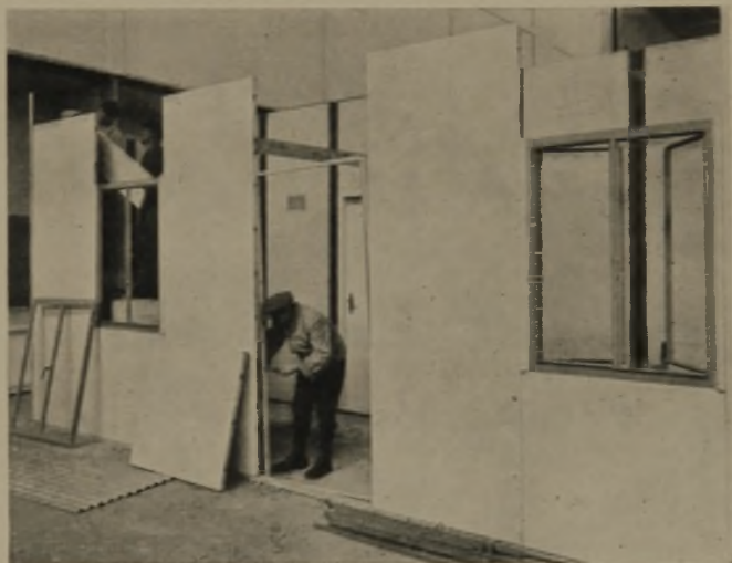
2 Stahlverwendung im Kleinwohnungsbau Fot. Ed. Krömer, Leipzig
