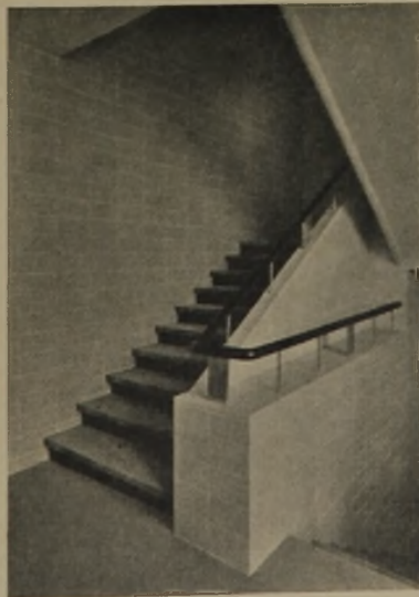
16 u. 17 Wandverkleidungen mit Siegersdorfer Platten im Außen- und Innenbau
