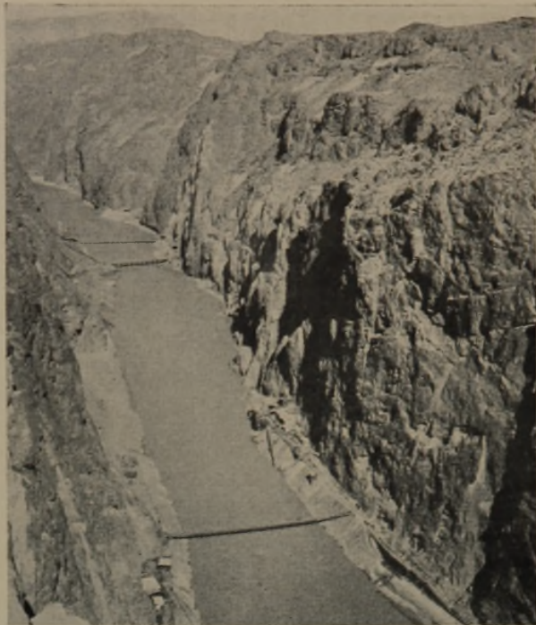
5 Blick in den „Black Canyon“ unterhalb der Talsperre
