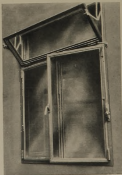
4 (Rechts) Stahl- Verbund-Fenster
