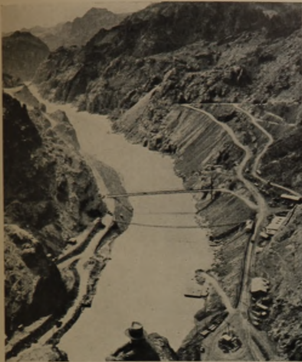
4 Blick auf die Baustelle am Colorado River
