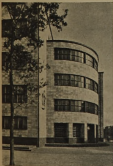
16 u. 17 Wandverkleidungen mit Siegersdorfer Platten im Außen- und Innenbau
