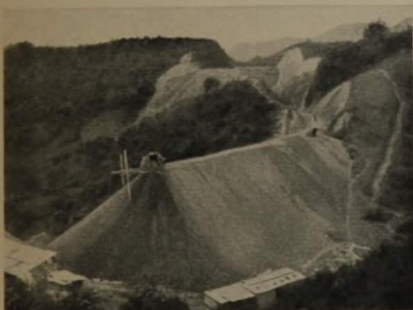
7 Talüberschreitung auf hohem Damm
