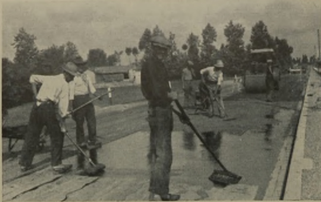
6 (Links) S. S. 9. „Via Emilia“ Aufbringung eines Teppich- belages auf Stampfasphalt
