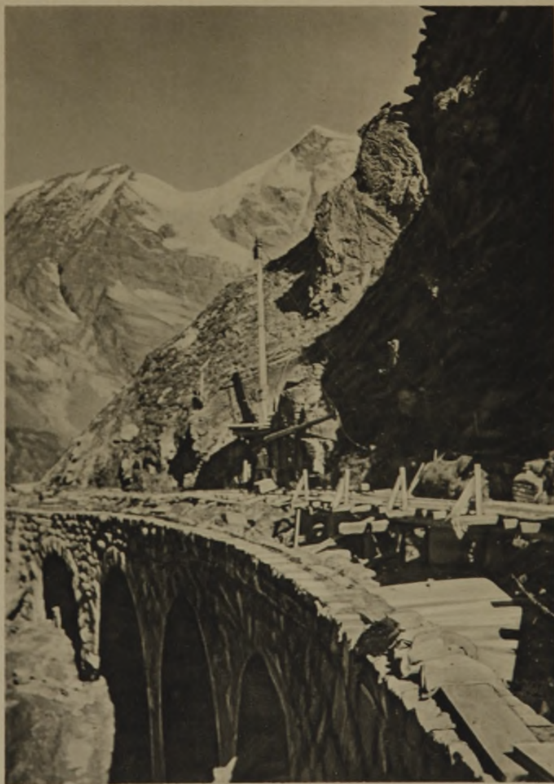
2 Bau eines Lehnengewölbes an der Edelweißwand, Scheitelstrecke
