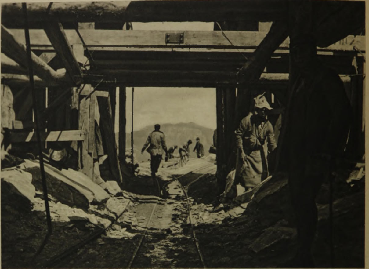
9 Ausblick aus dem nördlichen Portalring des Hochortunnels
