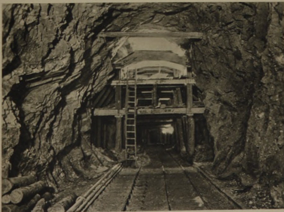
Bilder vom Bau der Großglockner-Hochalpenstraße
