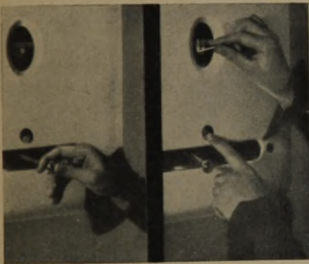
4 Inbetriebsetzung eines Gaswarmwasser- bereiters mit Zündflammsicherung
