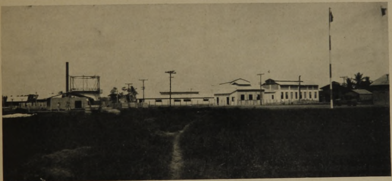
3 Gesamtbild der neu errichteten Anlage
